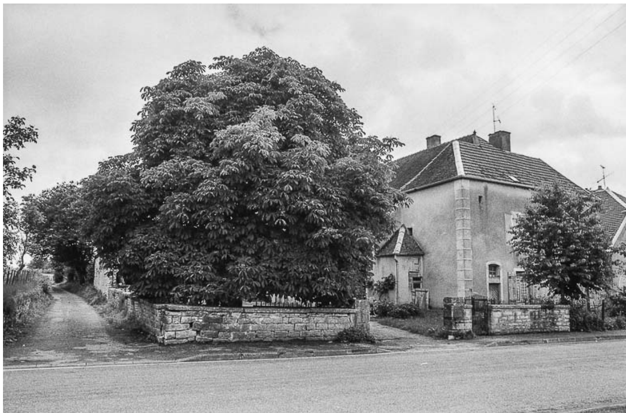
Vue d'ensemble depuis la rue.
