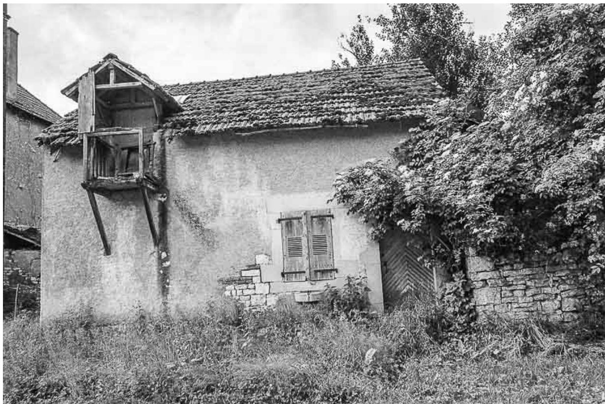
Maison cadastrée 1979 AB 10 : façade antérieure. 70, Broye-Aubigny-Montseugny
