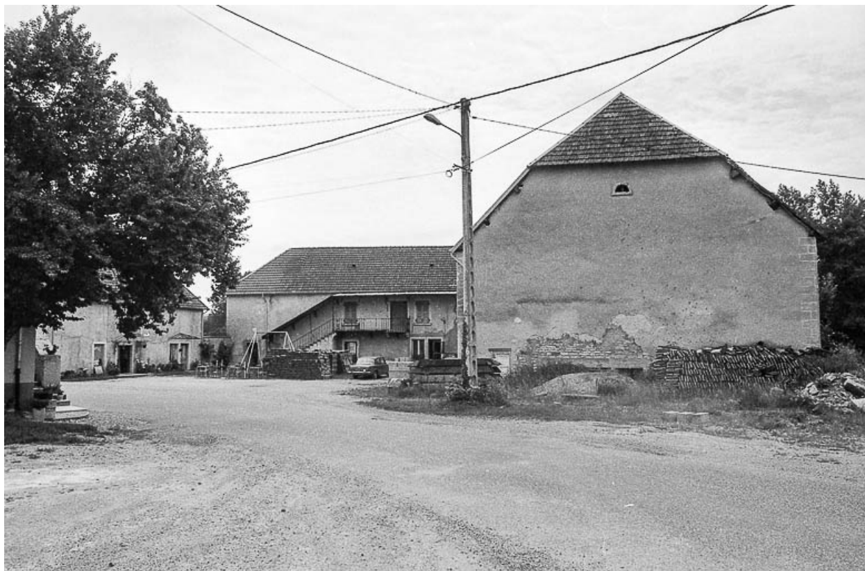
Vue d'ensemble des bâtiments en U. 70, Bresilley rue du Vieux Moulin
