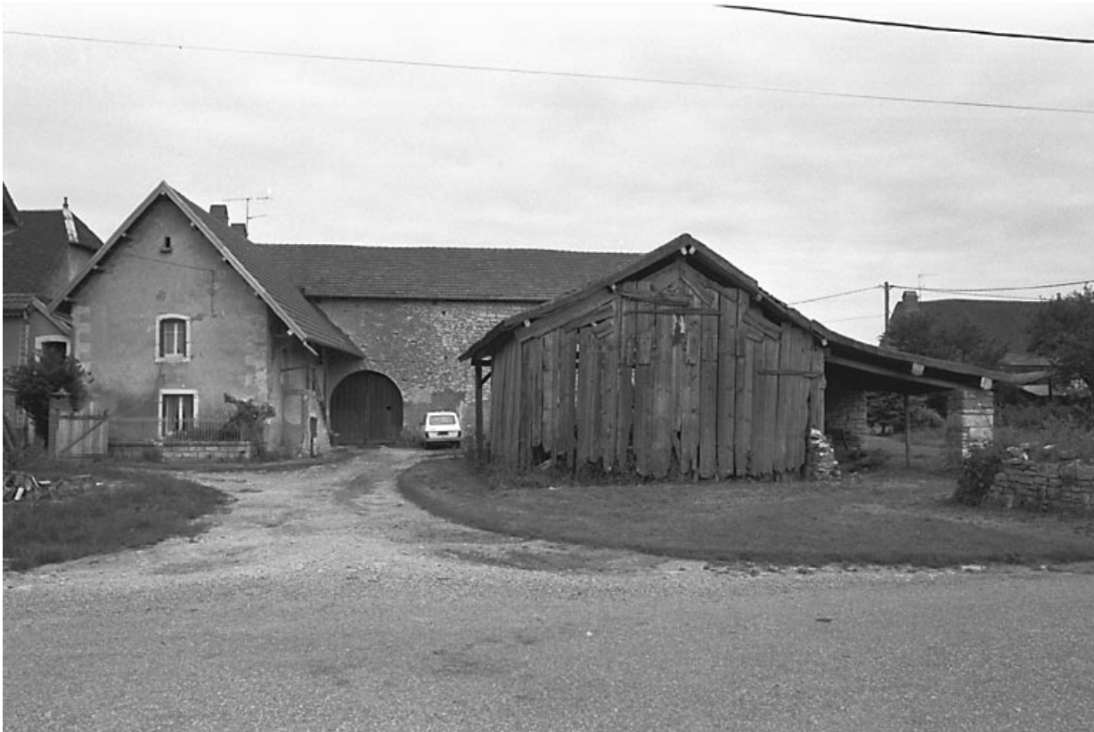
Vue rapprochée du bâtiment en L et du hangar.
