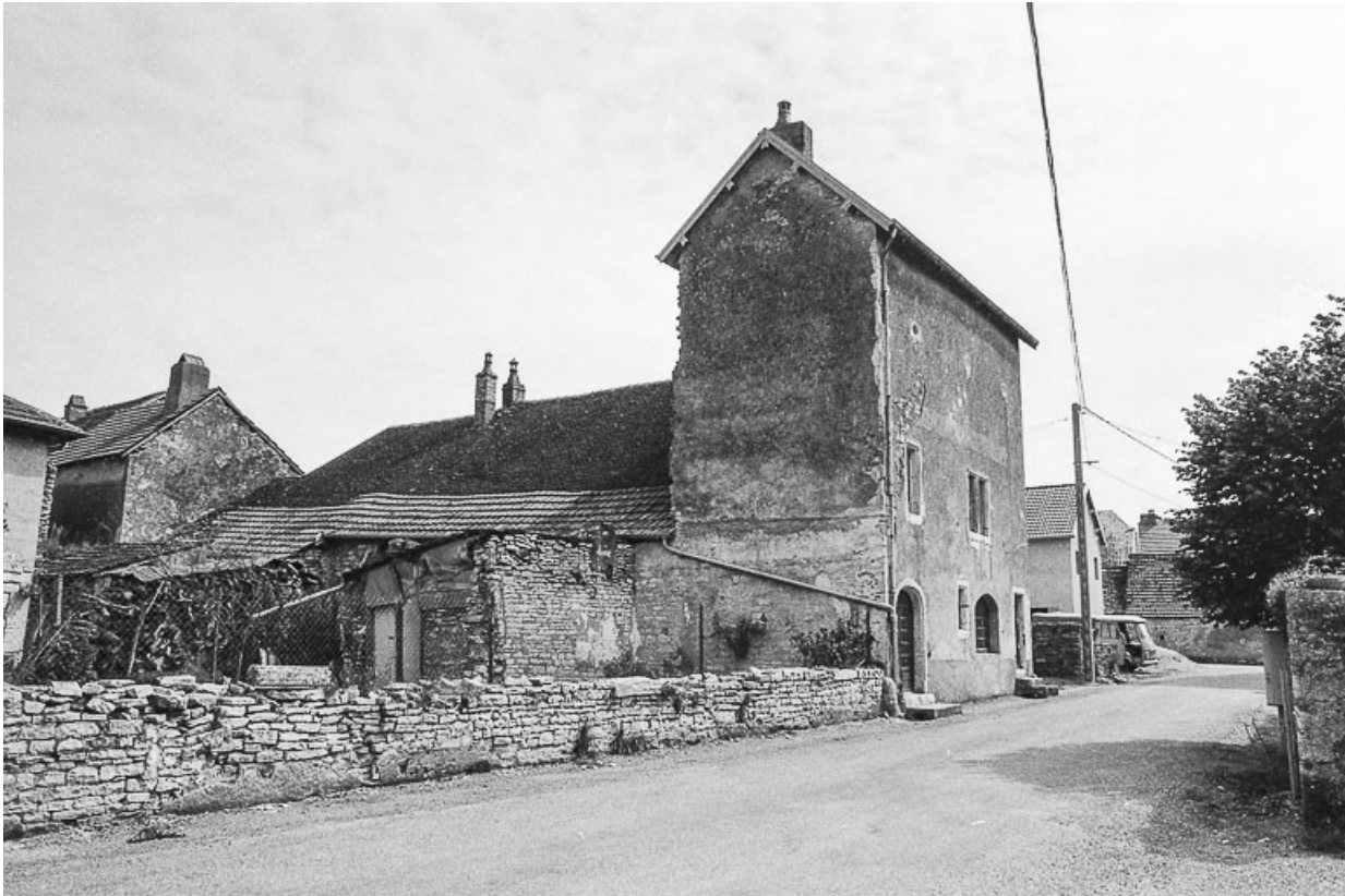
Vue d'ensemble : façade postérieure.
