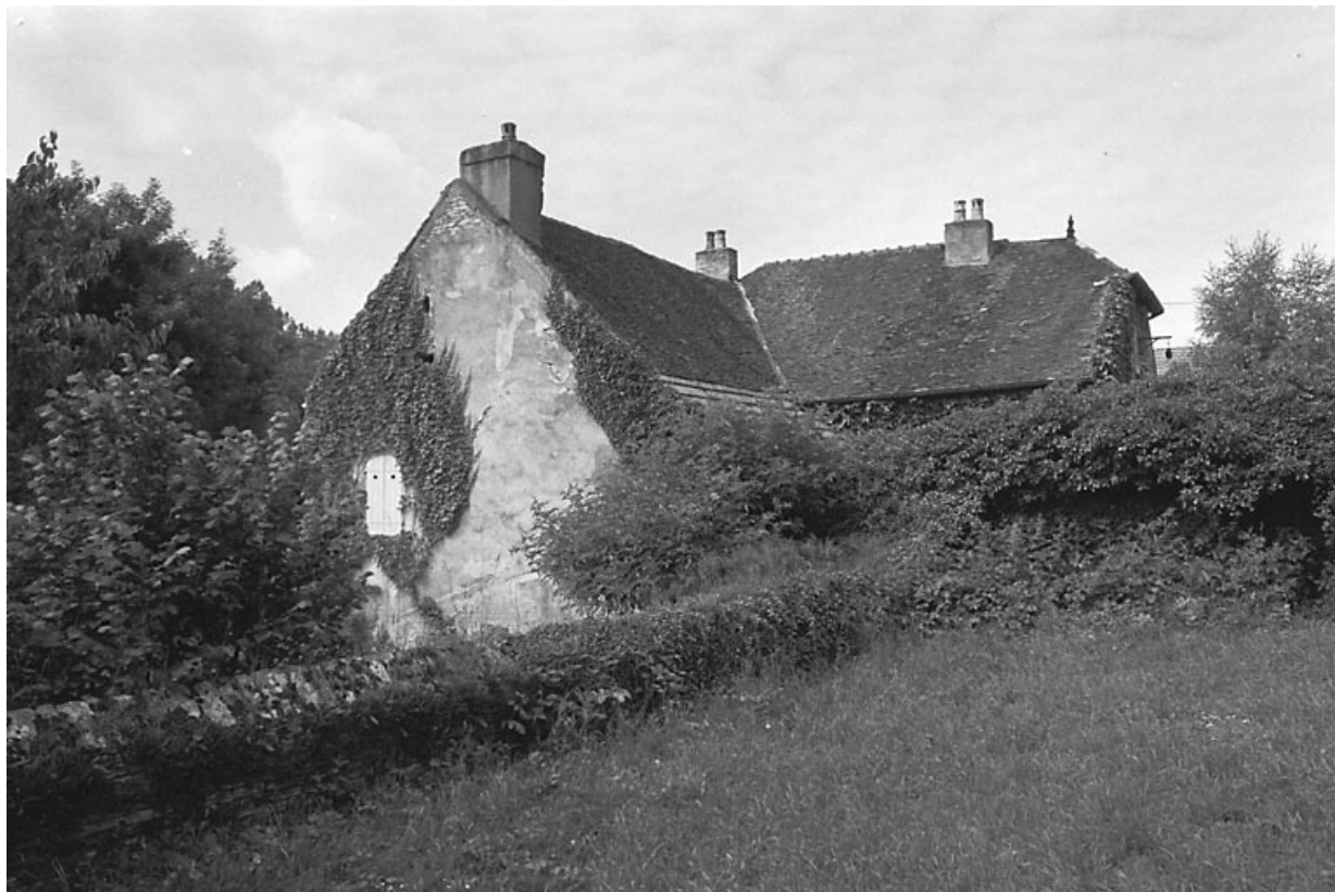
Vue d'ensemble depuis le parvis de l'église.
