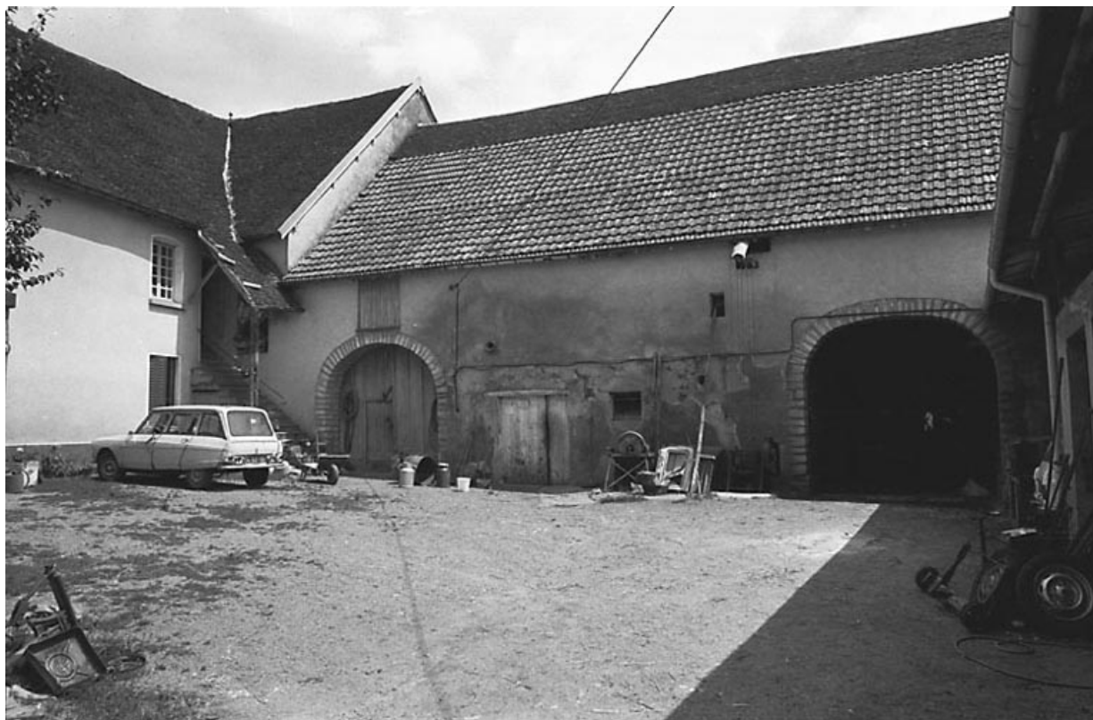
Vue des bâtiments agricoles dans la cour.
