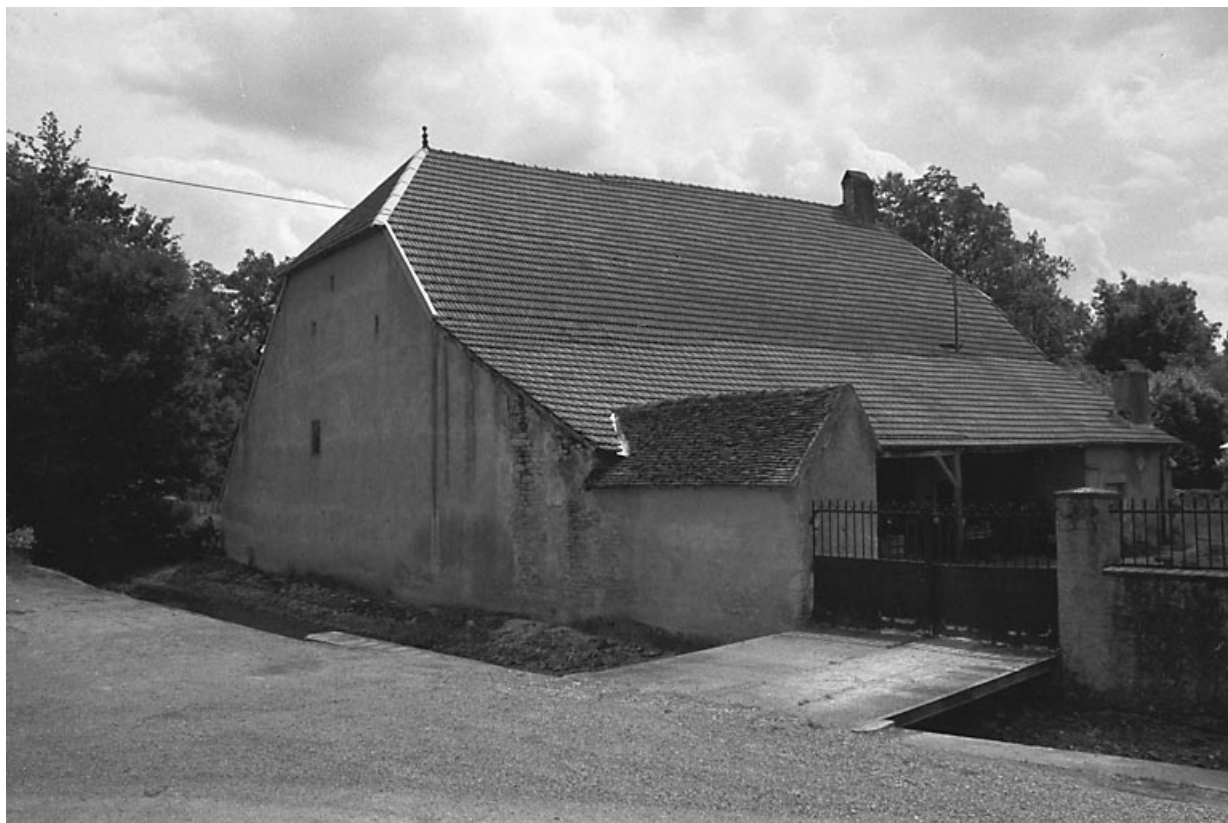
Façades antérieure et latérale gauche.
