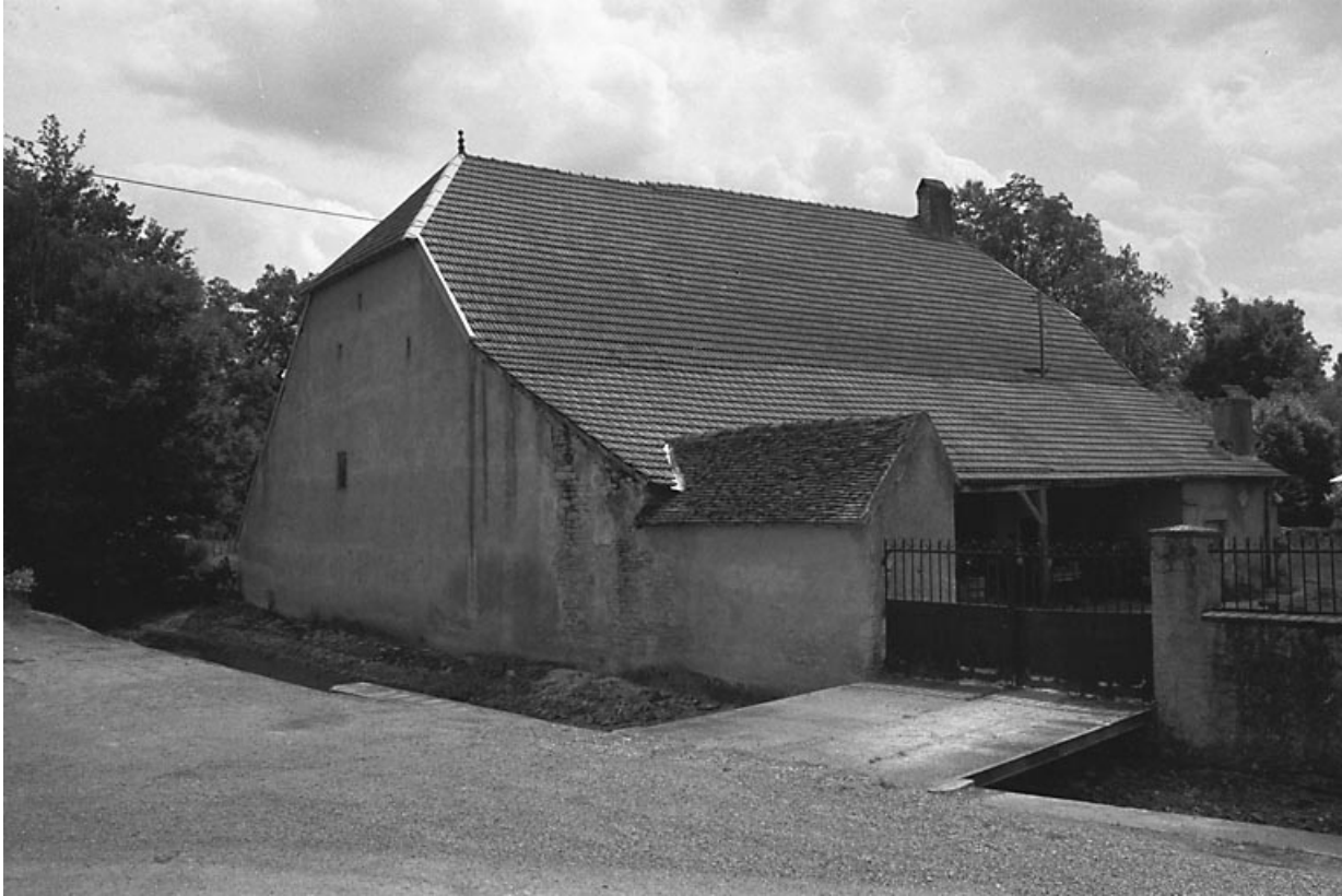
Façades antérieure et latérale gauche. 70, Bard-lès-Pesmes Grande Rue
