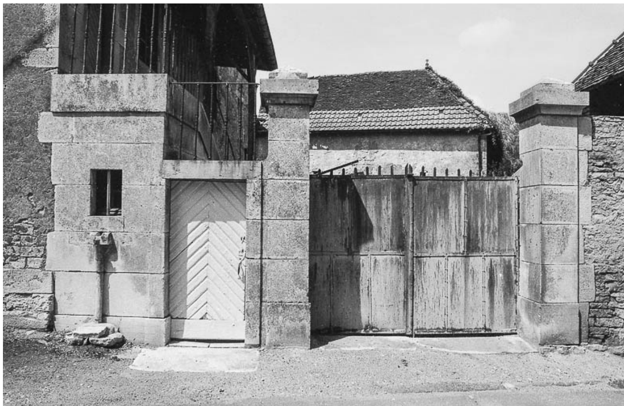
Vue rapprochée du portail d'entrée.
