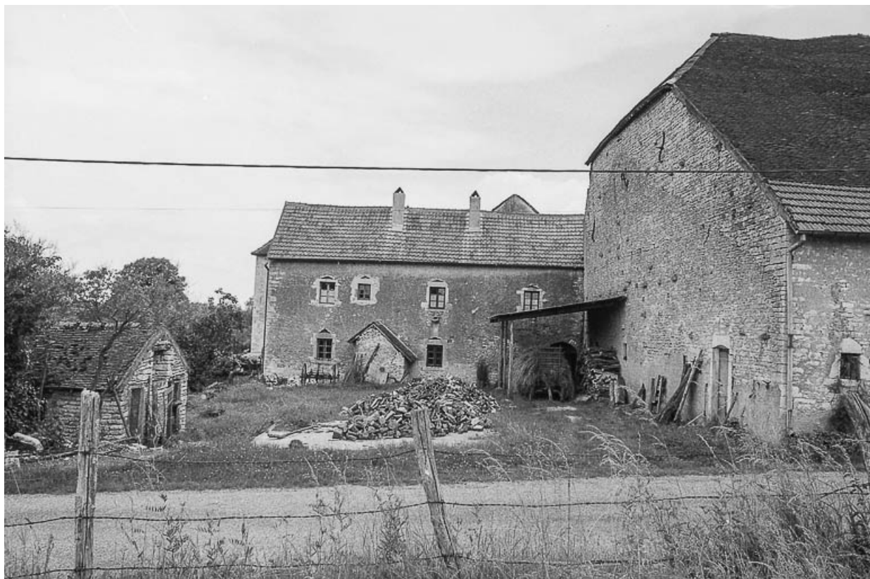
Façade postérieure sur cour.
