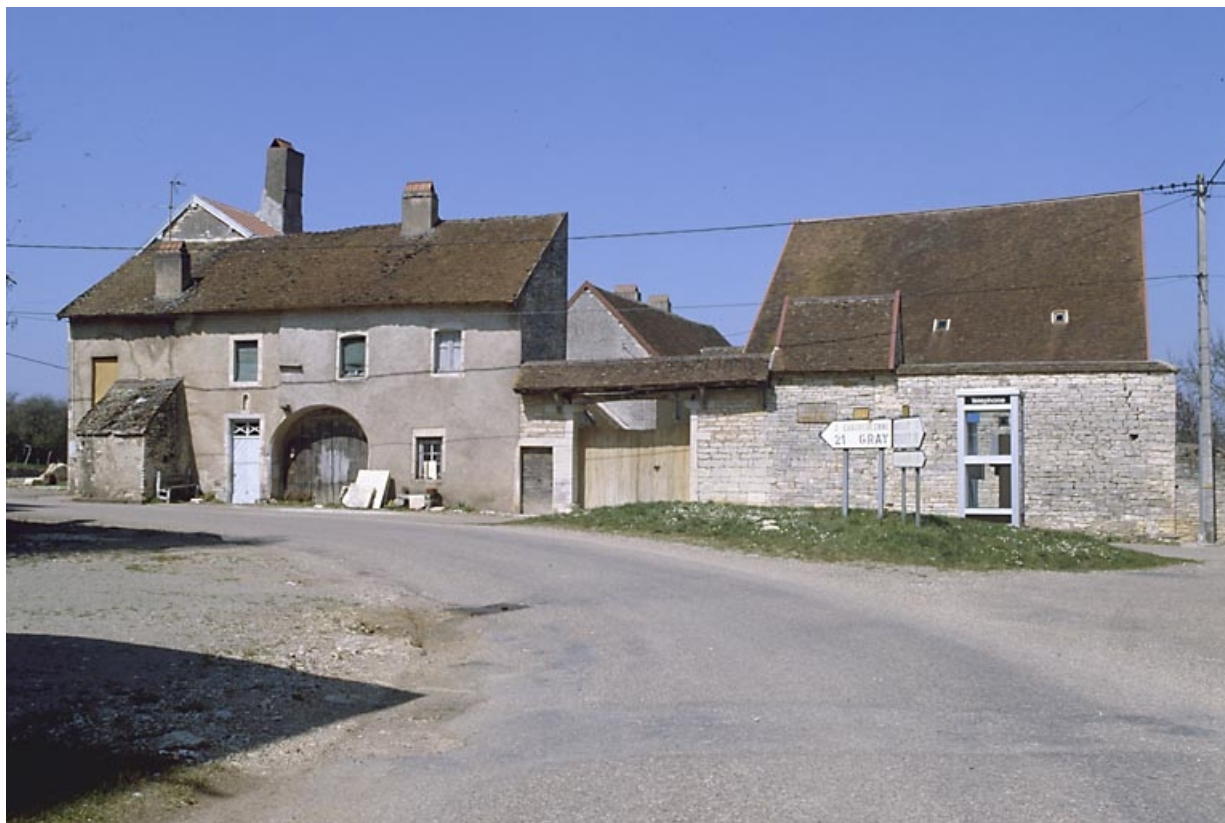
Vue d'ensemble après destruction du bâtiment agricole.
