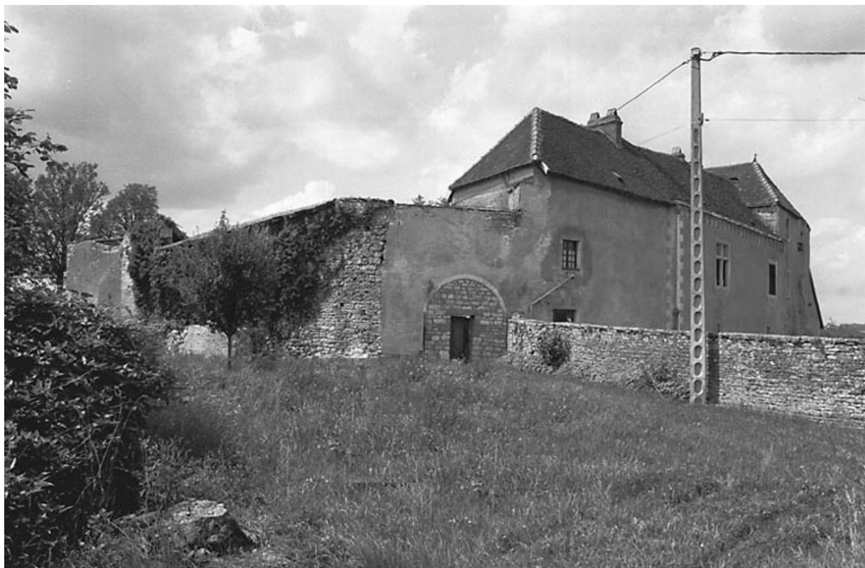
Façades postérieure et latérale droite.
