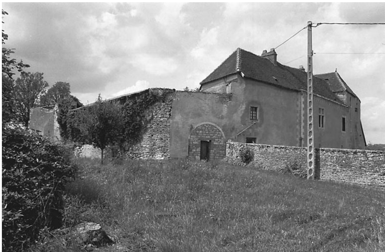
Façades postérieure et latérale droite.
