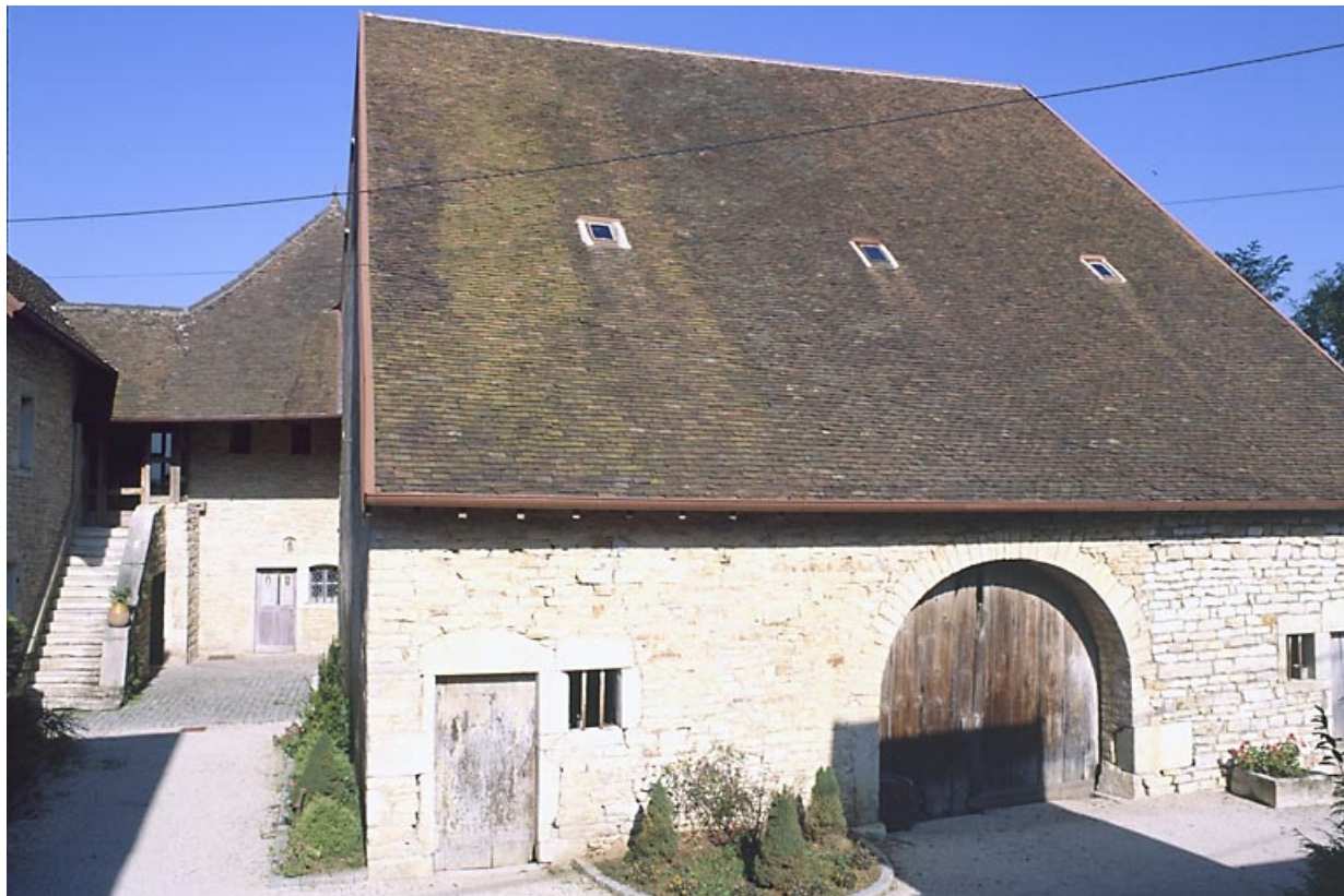
Les parties agricoles situées dans la cour.
