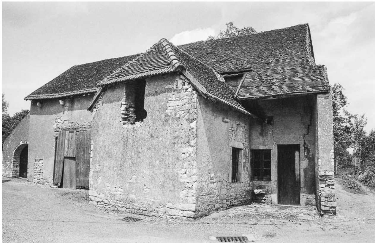
Ferme cadastrée ZD 39, située rue des Tantots : vue d'ensemble. 70, Bard-lès-Pesmes
