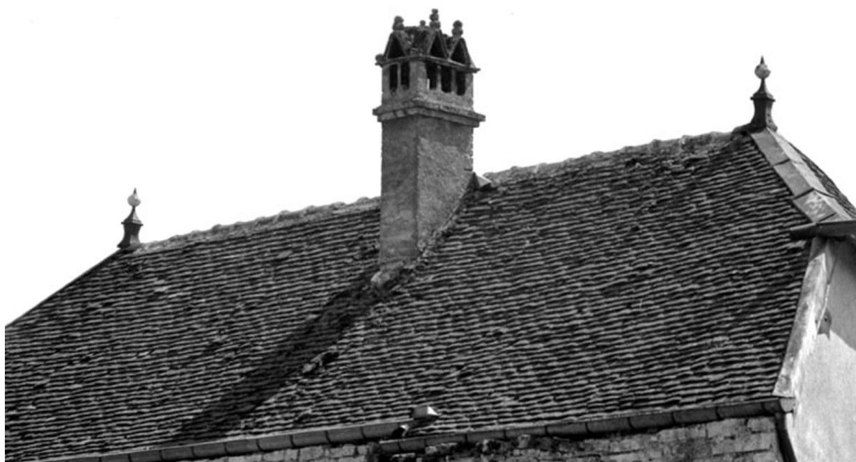
Détail du toit recouvert de tuiles plates
