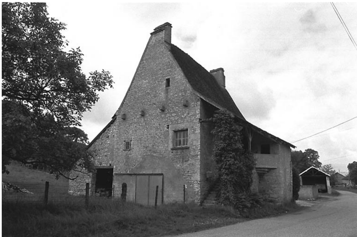
Façades antérieure et latérale gauche.
