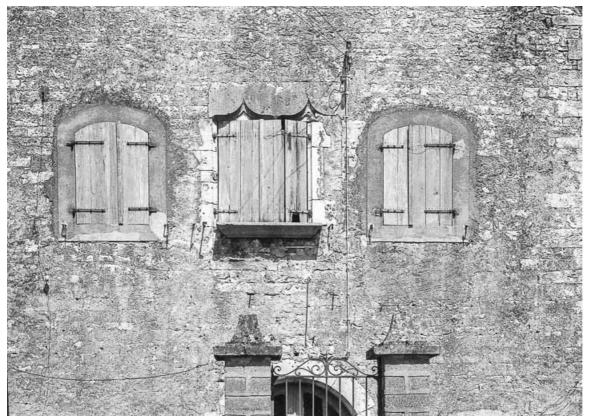
Mur en moellons calcaires recouverts d'enduit
