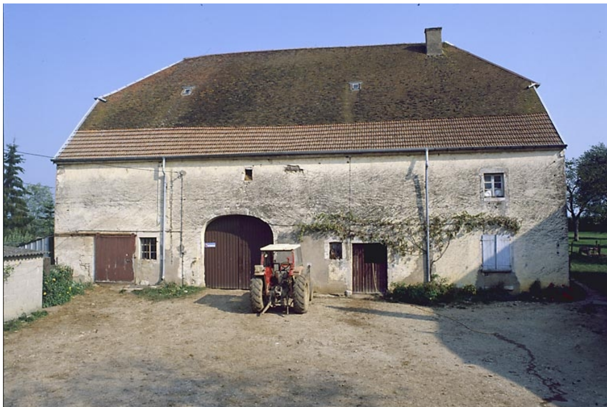
Façade sur cour.
