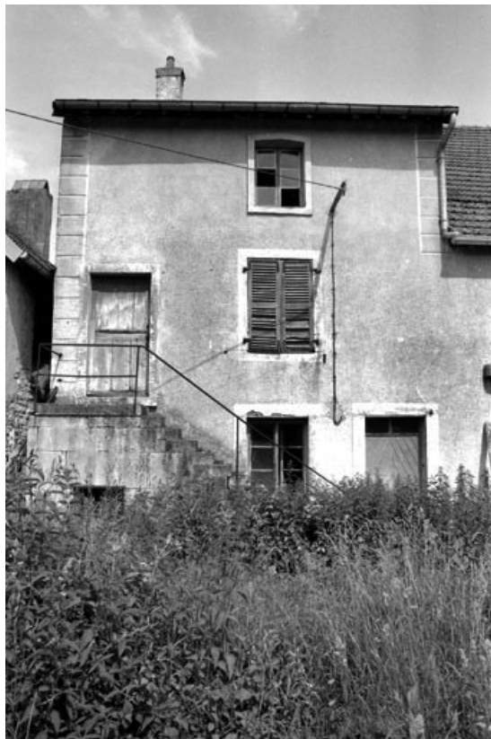
Ferme cadastrée 1970 B 54, située rue Gazelle : façade postérieure.
