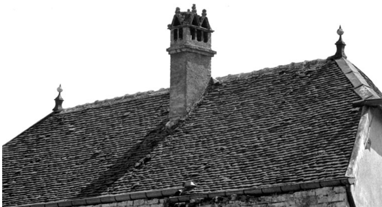
Détail du toit recouvert de tuiles plates
