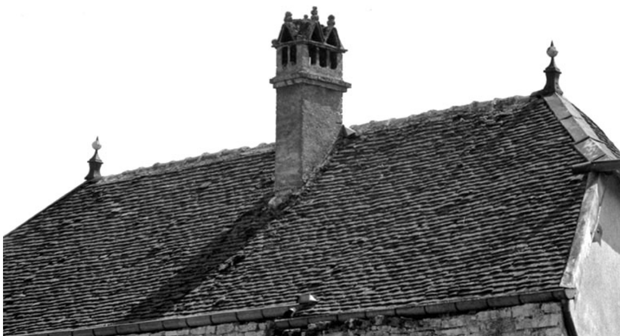
Détail du toit recouvert de tuiles plates
