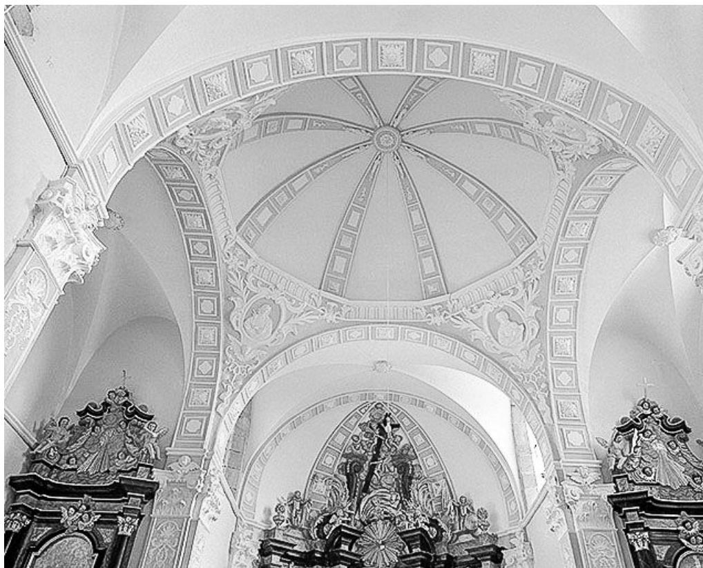
Intérieur : coupole de la croisée du transept, voûtes du chœur et des bras du transept.
