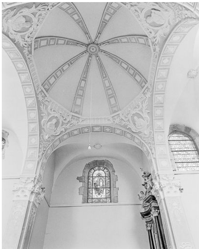
Intérieur : coupole de la croisée du transept et voûte du bras du transept gauche. 70, Villers-Chemin-et-Mont-lès-Étrelles rue de l'Église, lieudit : Mont-les-Etrelles
