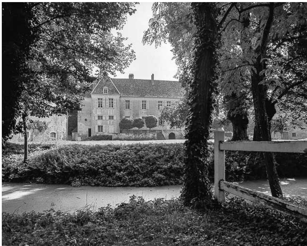
Façade sur jardin et fossé.
