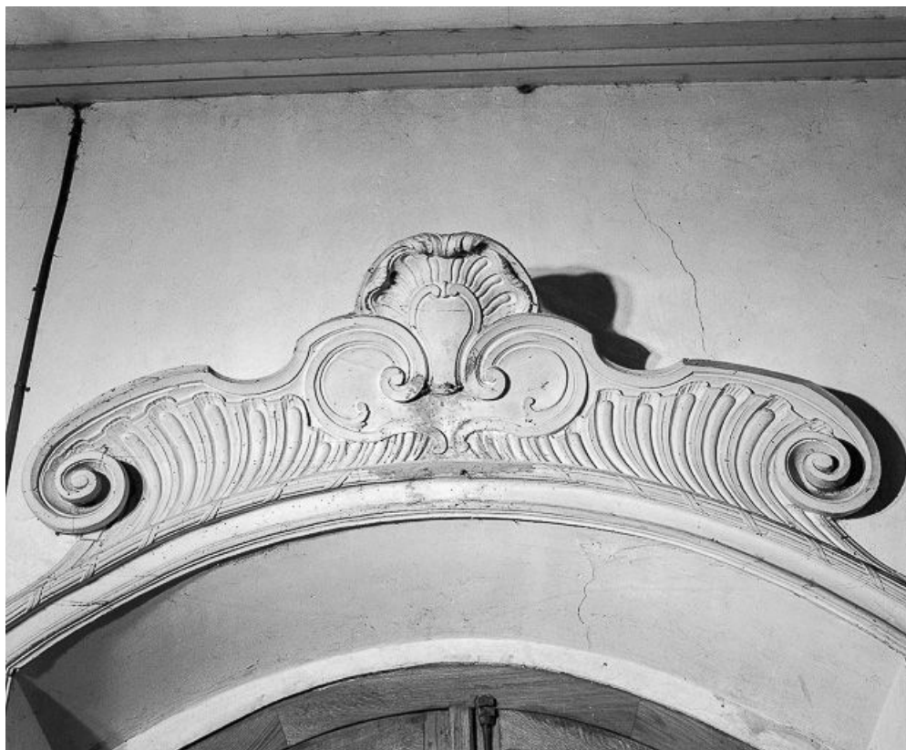
Intérieur : couronnement de la porte d'entrée.
