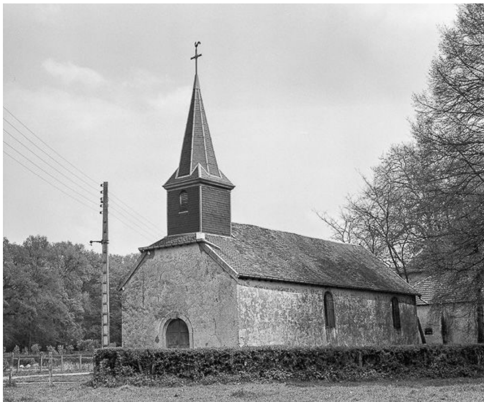
Façades antérieure et latérale droite.
