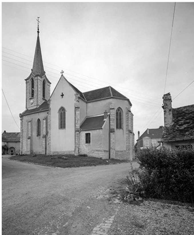
Extérieur : façade latérale droite.
