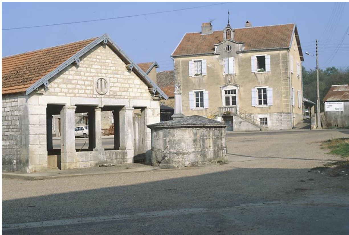
Détail de la fontaine.
