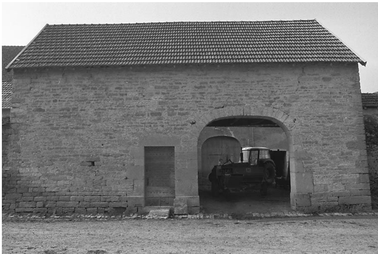
Bâtiment d'entrée depuis la rue regroupant diverses fonctions : porcherie, remise et bûcher.
