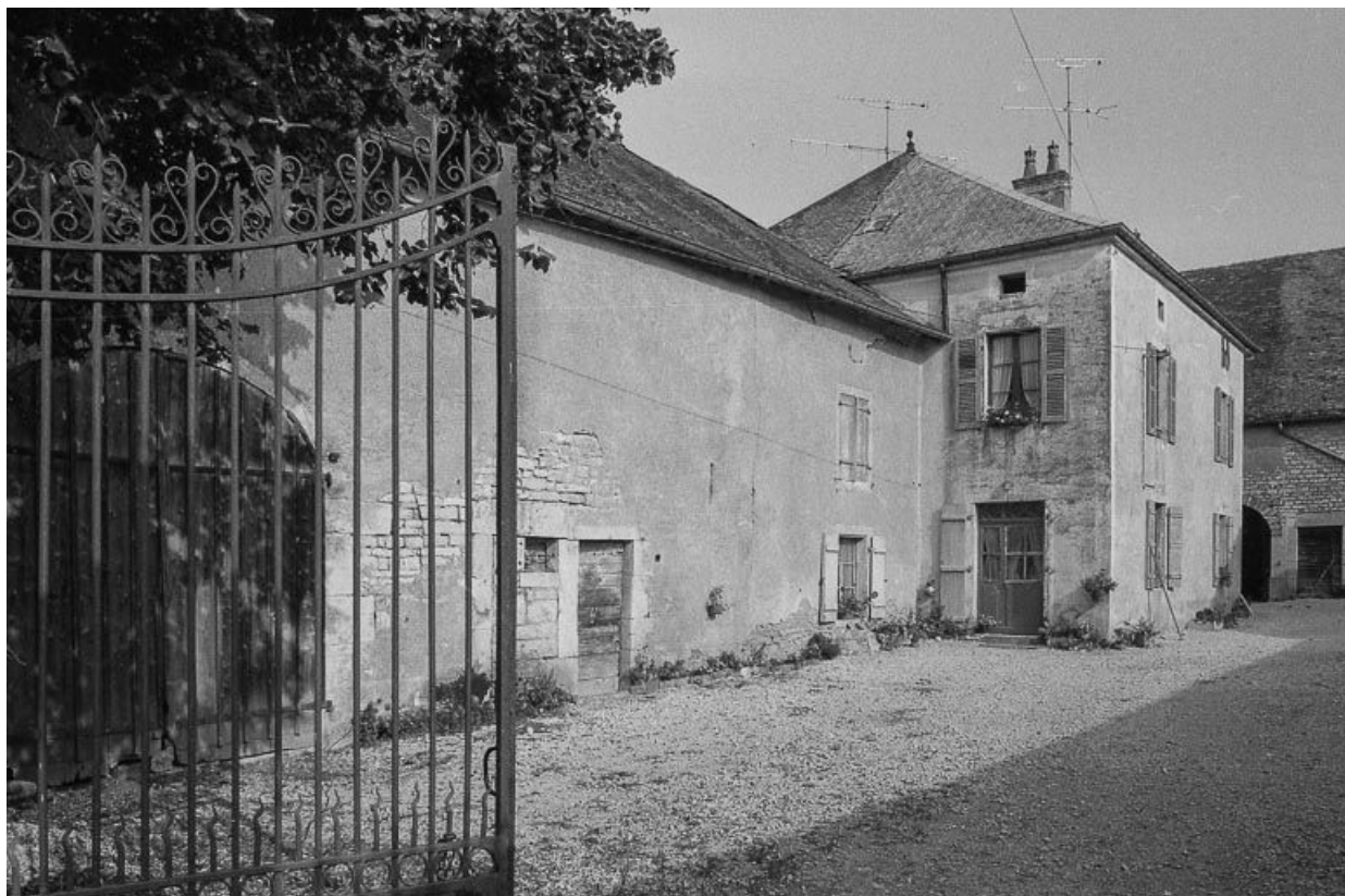
Habitation et parties agricoles sur le côté gauche de la cour.
