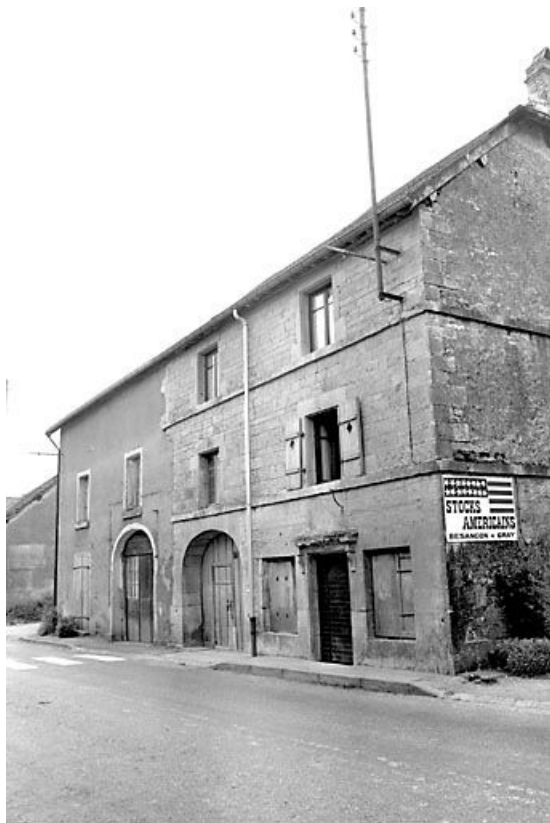
Vue d'ensemble avec façade antérieure en pierre de taille. 70, Oiselay-et-Grachaux
