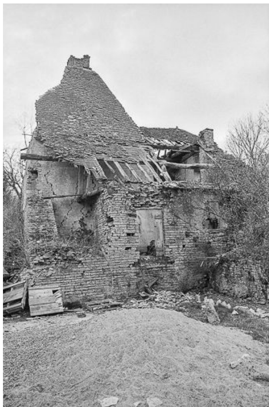
Bâtiment B : restes d'un logement (appartenant à M. Faivre). 70, Oiselay-et-Grachaux rue de la Tuilerie, lieudit : Oiselay
