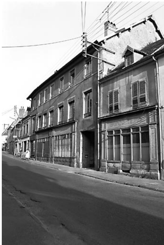
Façade antérieure avec magasins au rez-de-chaussée.
