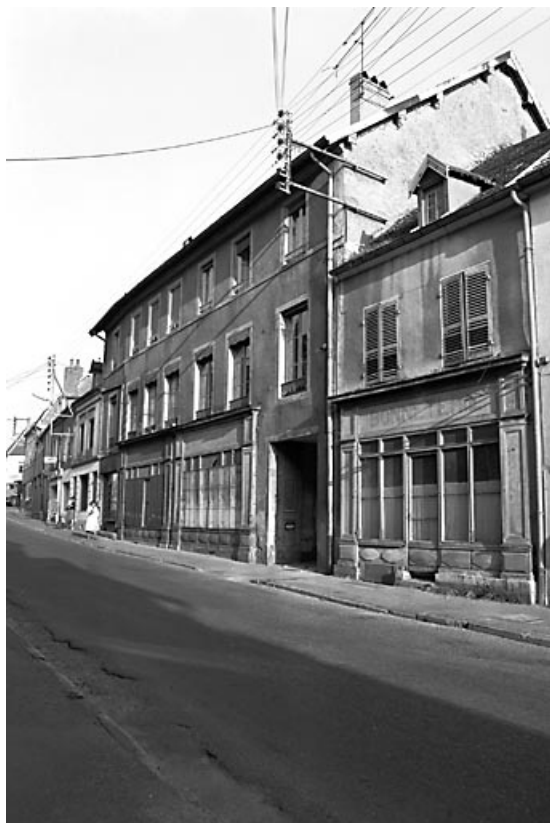
Façade antérieure avec magasins au rez-de-chaussée.
