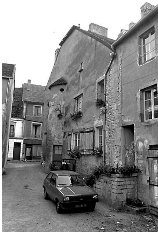
Façade latérale droite sur cour.
