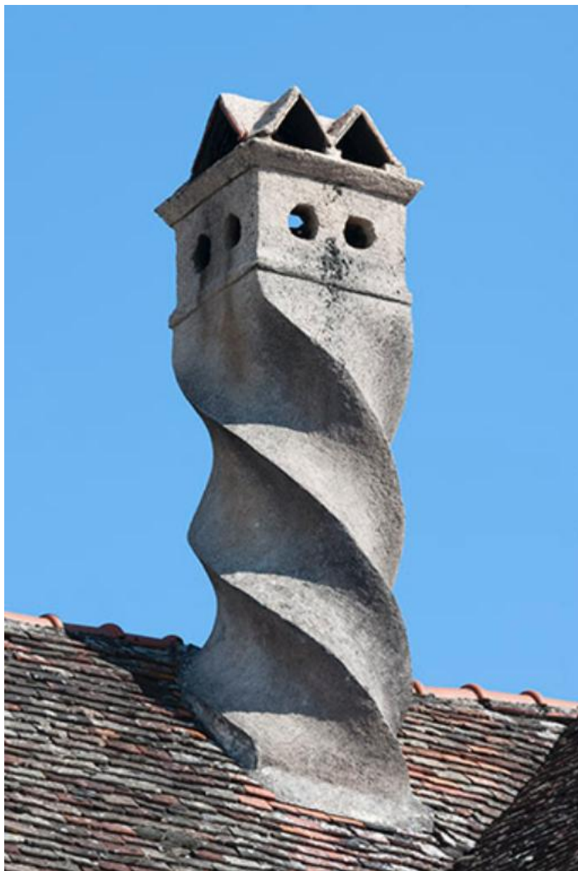
Détail de la souche de cheminée torse
