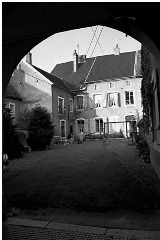
Façade antérieure sur cour.
