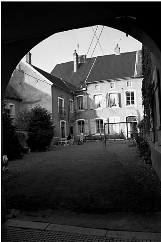
Façade antérieure sur cour.
