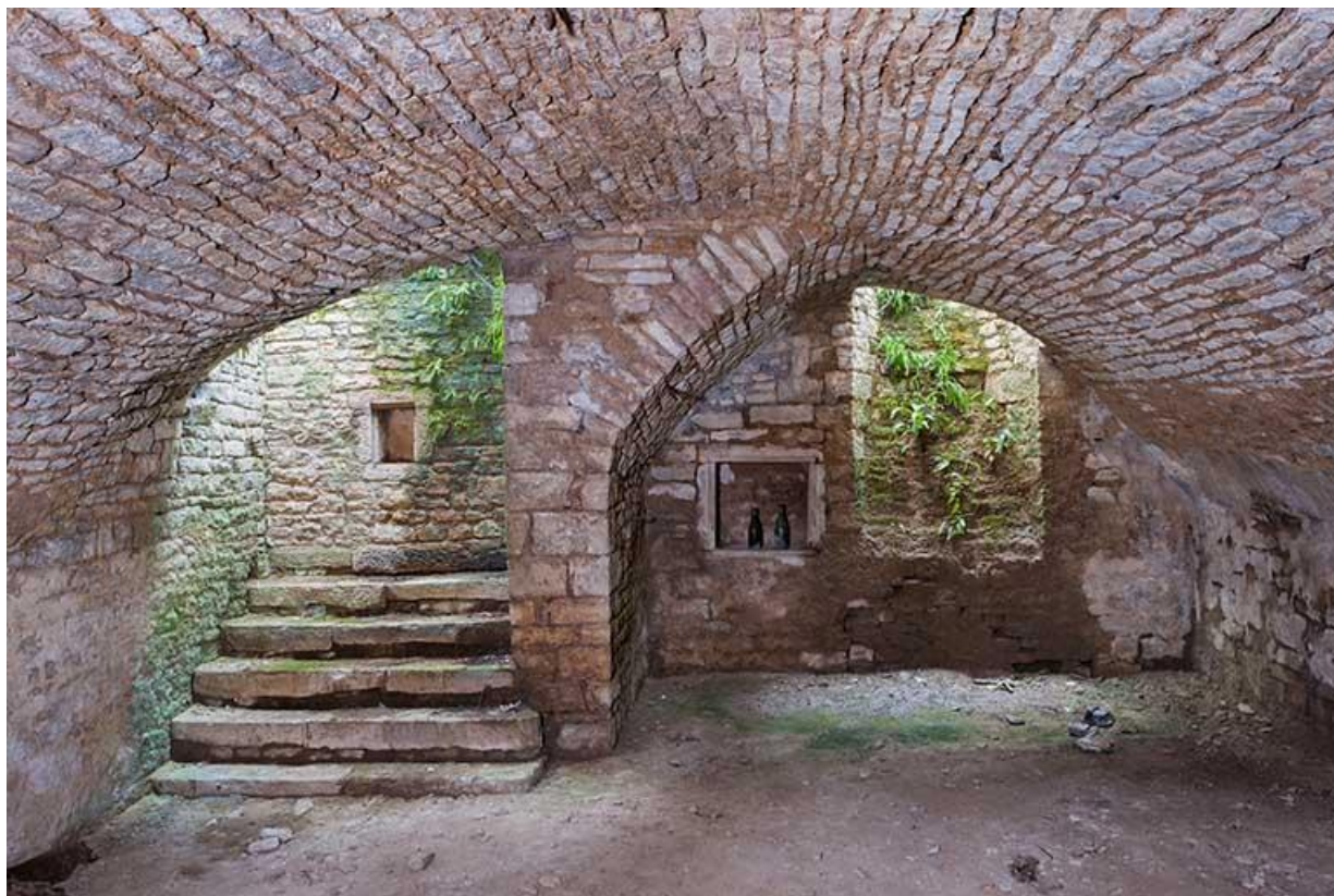
Vue générale de la cave
