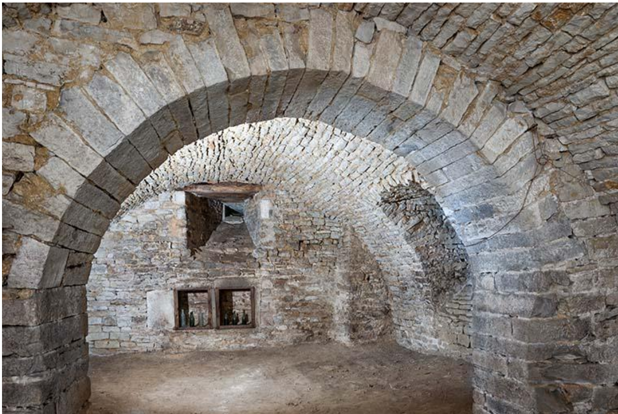
Vue générale de la cave
