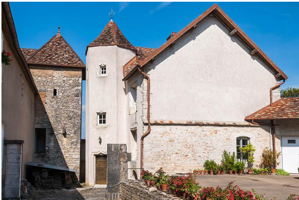
Ancienne maison située au nord-ouest
