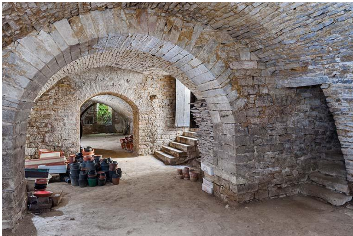
Vue générale de la cave
