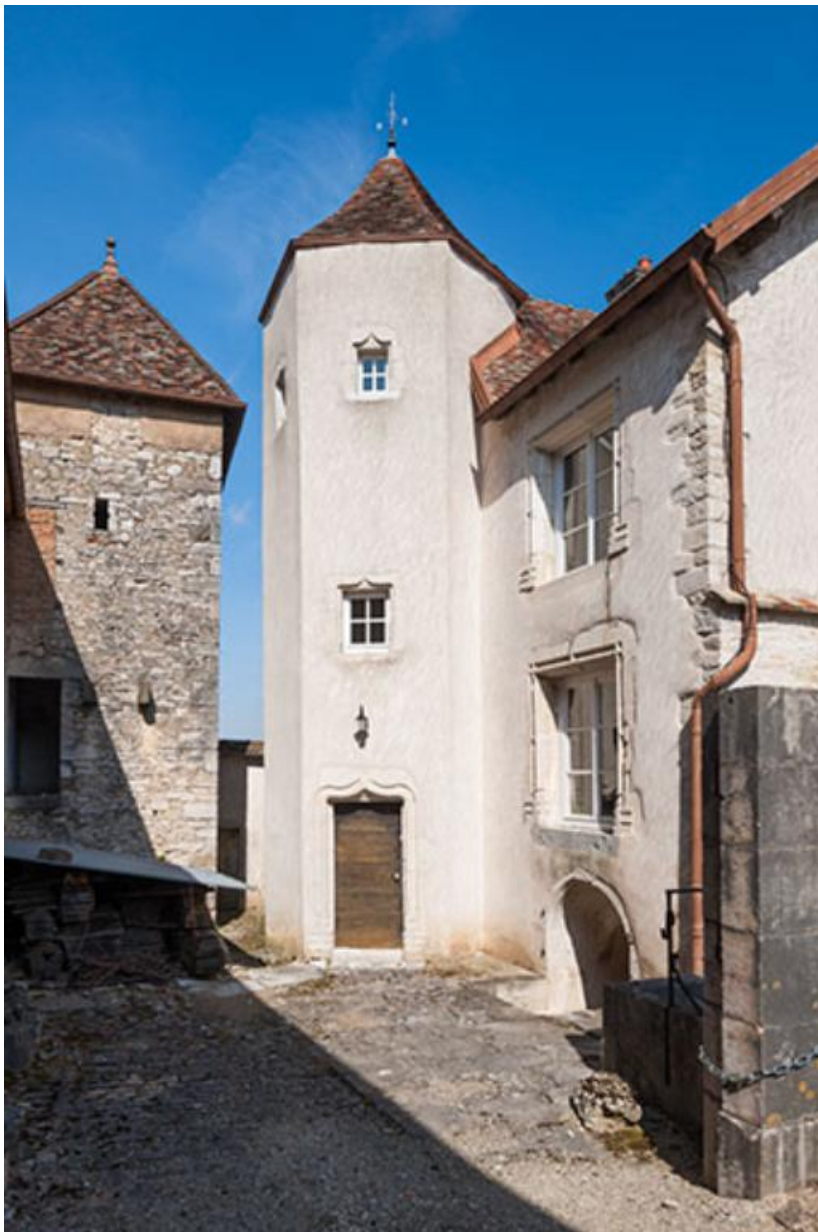
Tour d'escalier de l'ancienne maison située au nord-ouest
