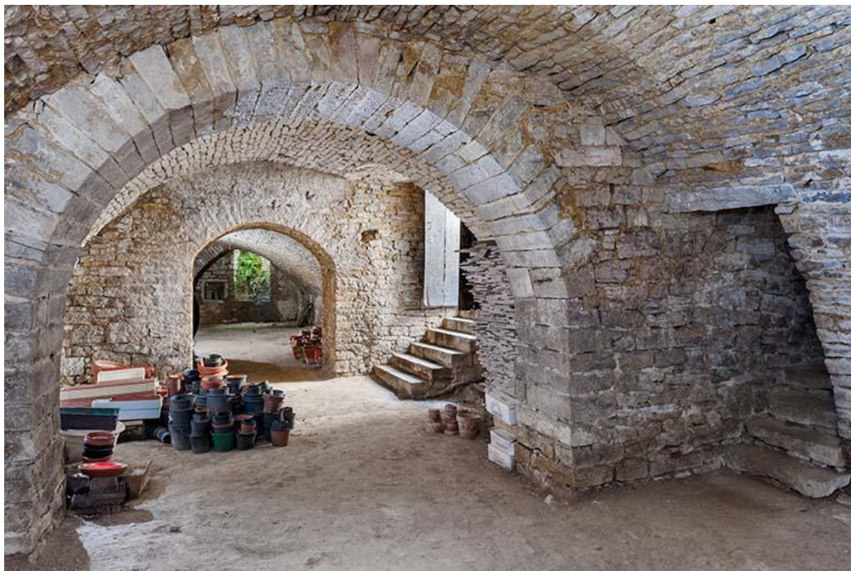
Vue générale de la cave
