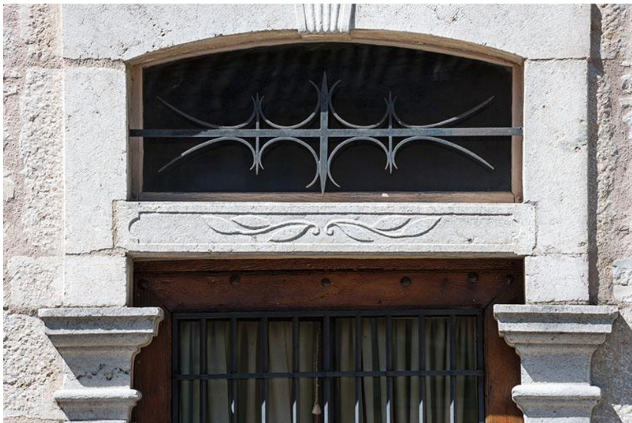
Détail de l'imposte au-dessus de la porte
