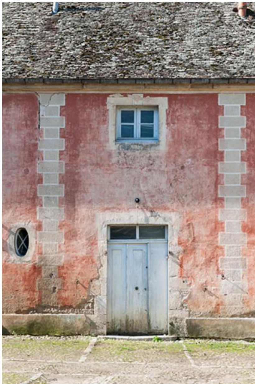
Détail de la partie centrale du bâtiment de dépendance
