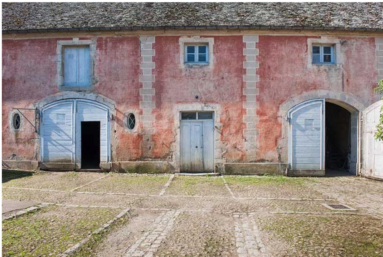
Détail de la façade est du bâtiment de dépendances
