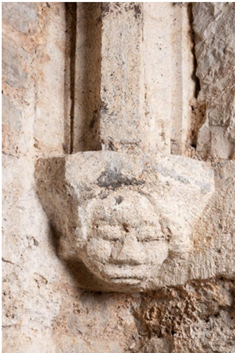
Détail d'un culot de retombée de la voute sur croisées d'ogives
