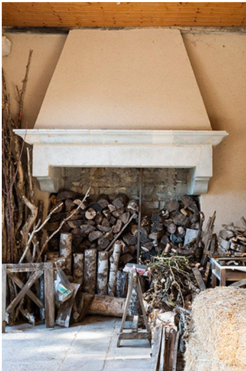
Cheminée située sous le porche
