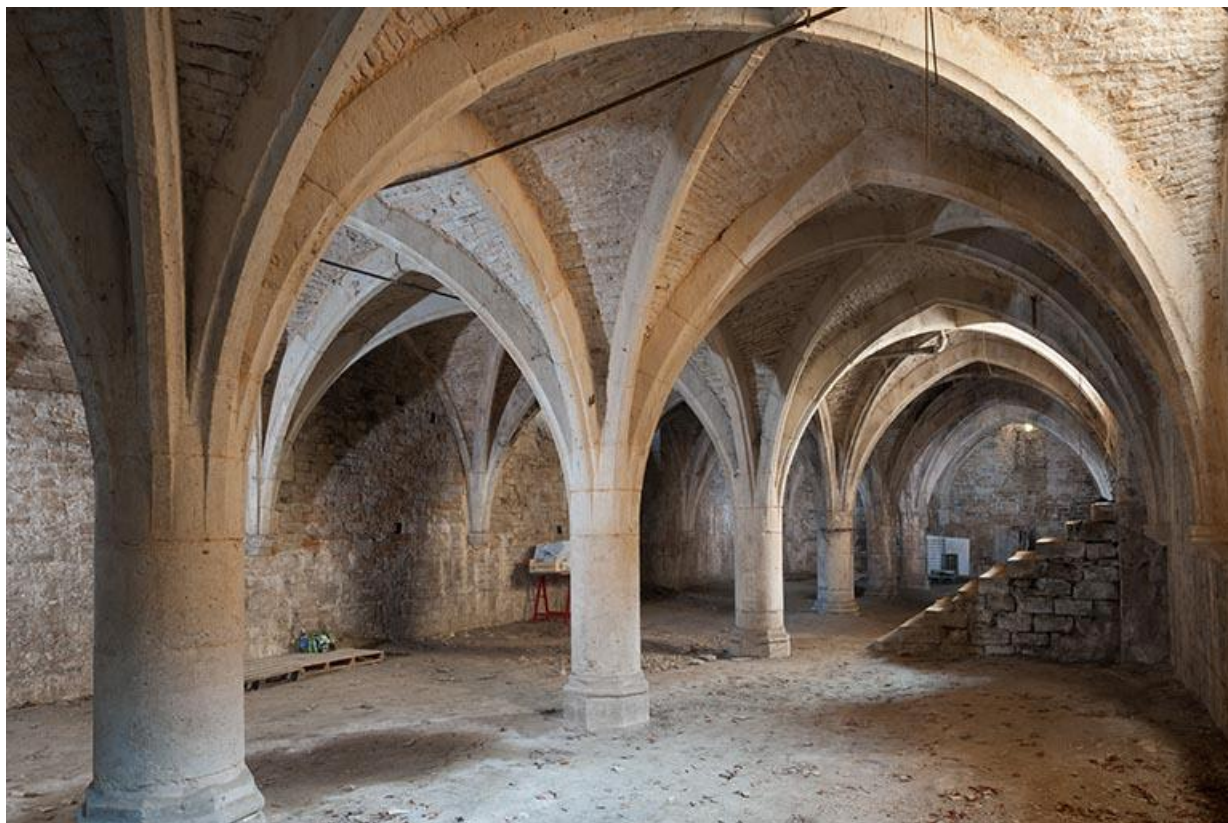
Vue générale de la cave voûtée sur croisées d'ogives
