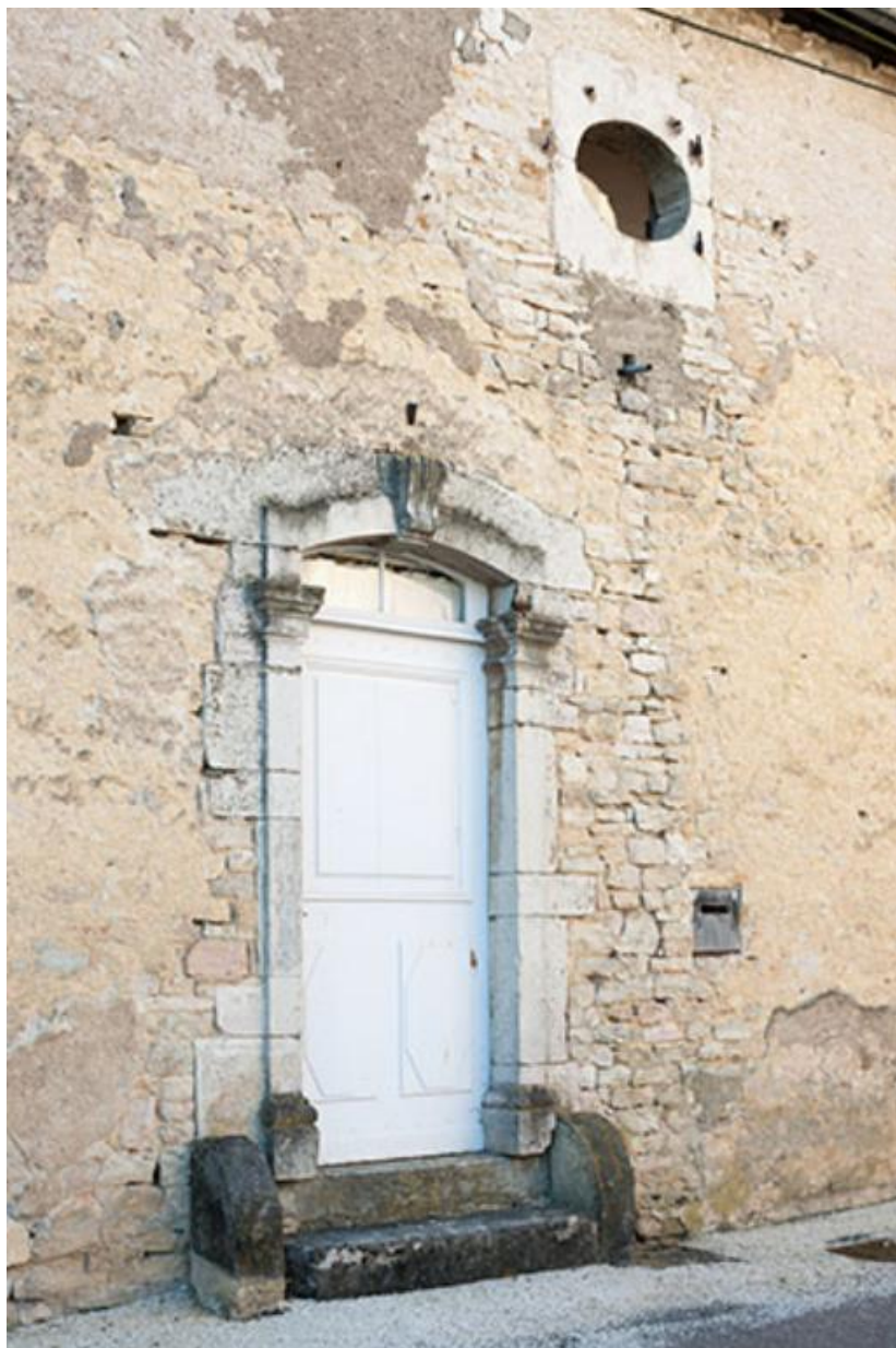
Détail de l'une des portes donnant sur la rue Ménans
