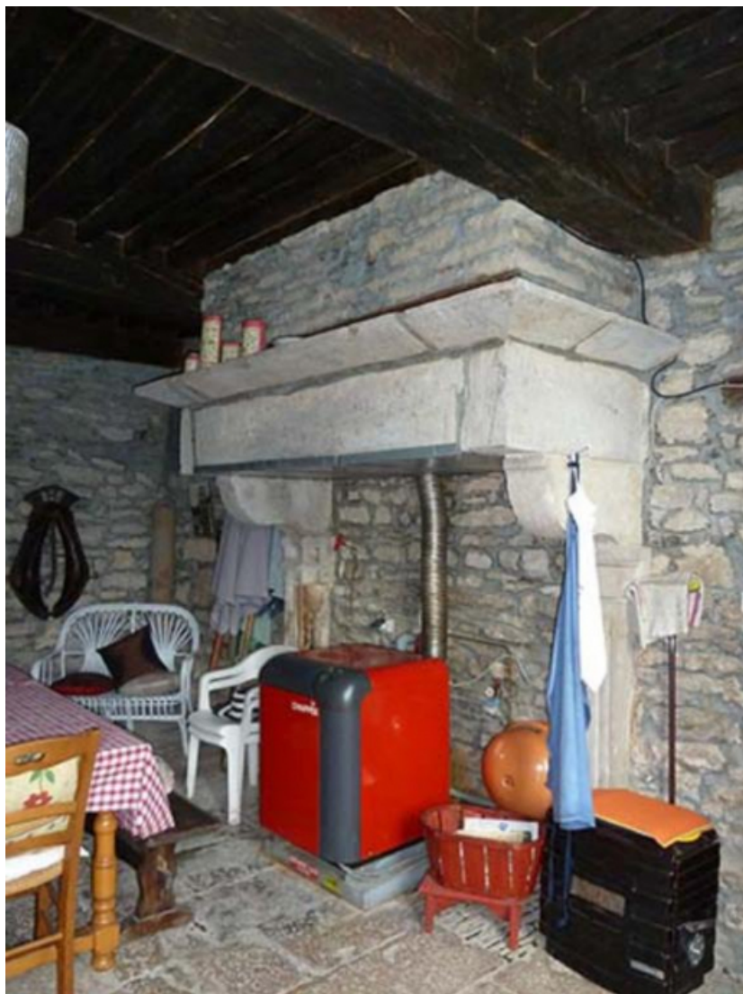
Cheminée située au rez-de-chaussée de la partie nord de la construction 70, Gy, 8-10 rue des Capucins
