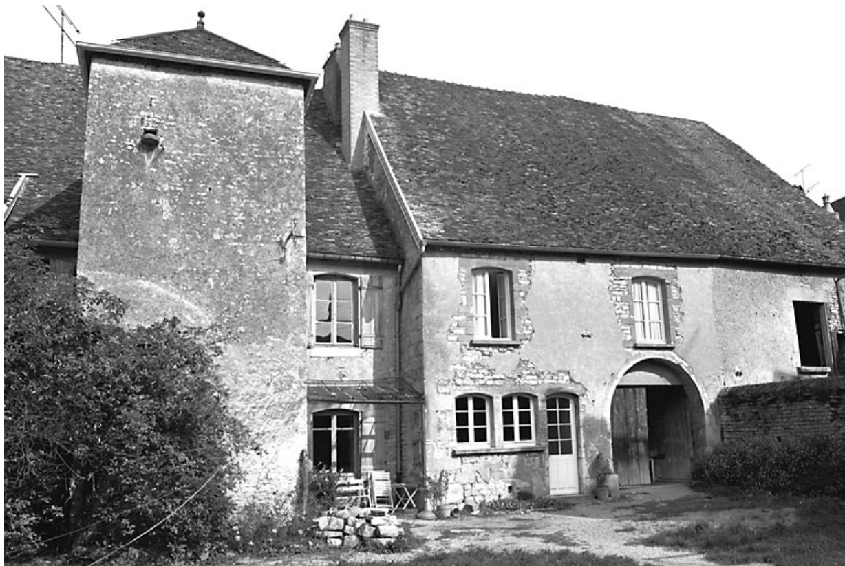
Façade sur cour.
