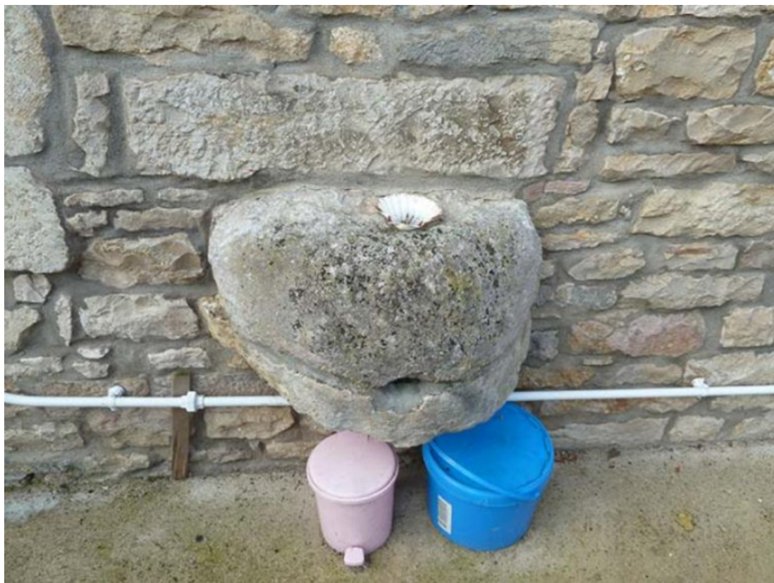
"Goulotte" d'évacuation de l'évier intérieur
