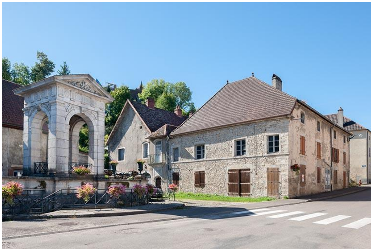
Vue d'ensemble nord-est
