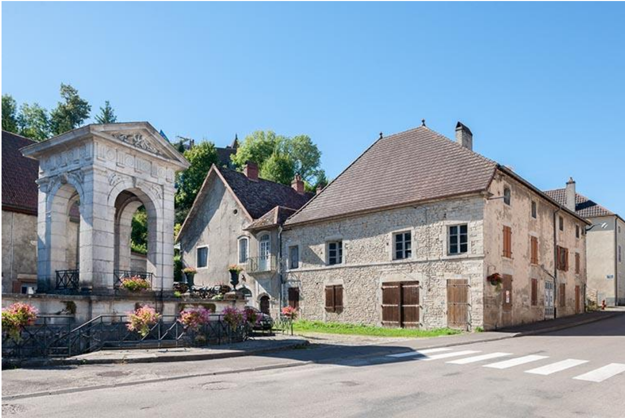
Vue d'ensemble nord-est
