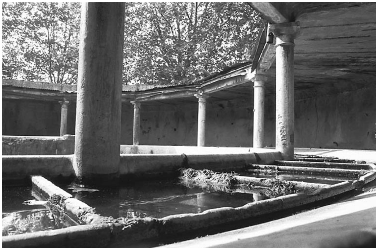
Vue de détail : compartimentage du bassin pour les lessives individuelles.
