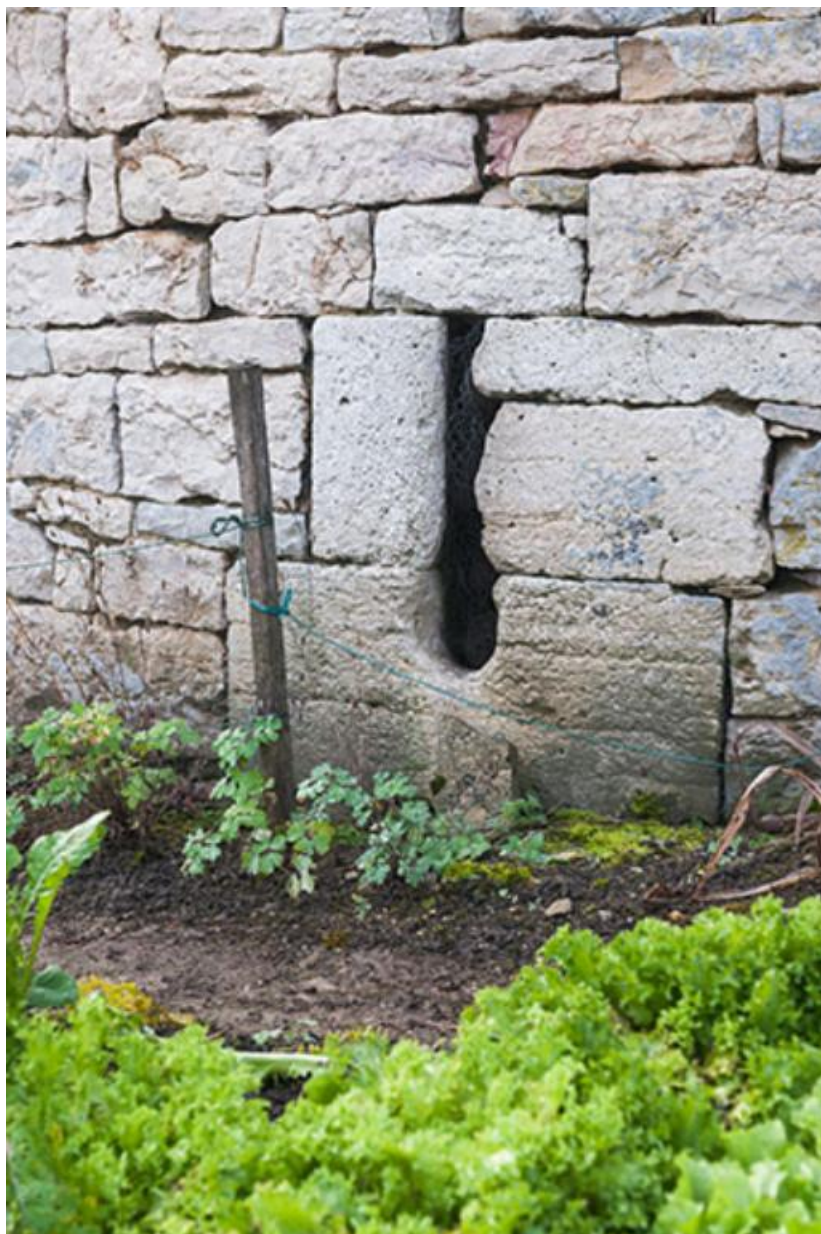
Détail de l'une des meurtrières de la tour 70, Gy
