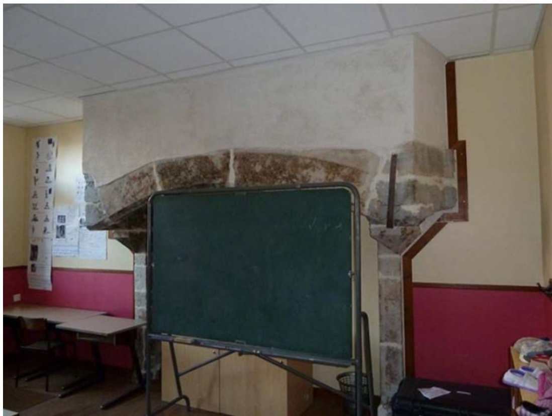
Cheminée monumentale, adossée à la précédente
