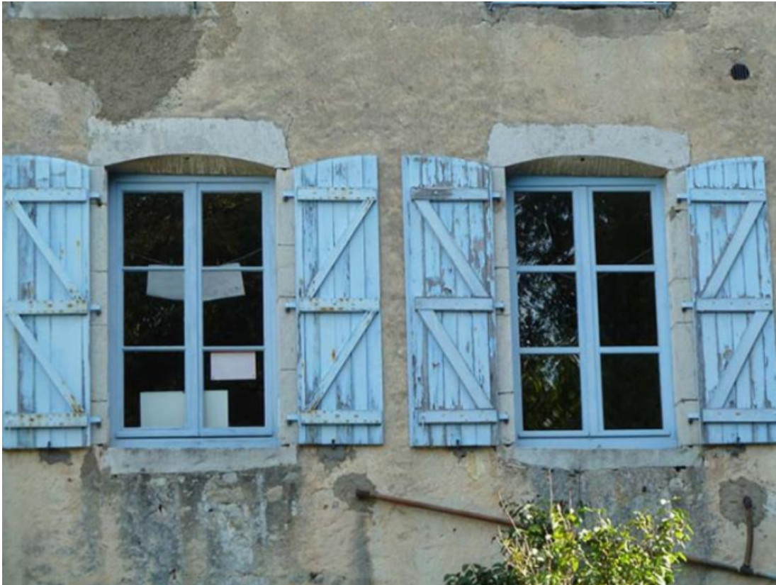
Détail des baies de la façade ouest
