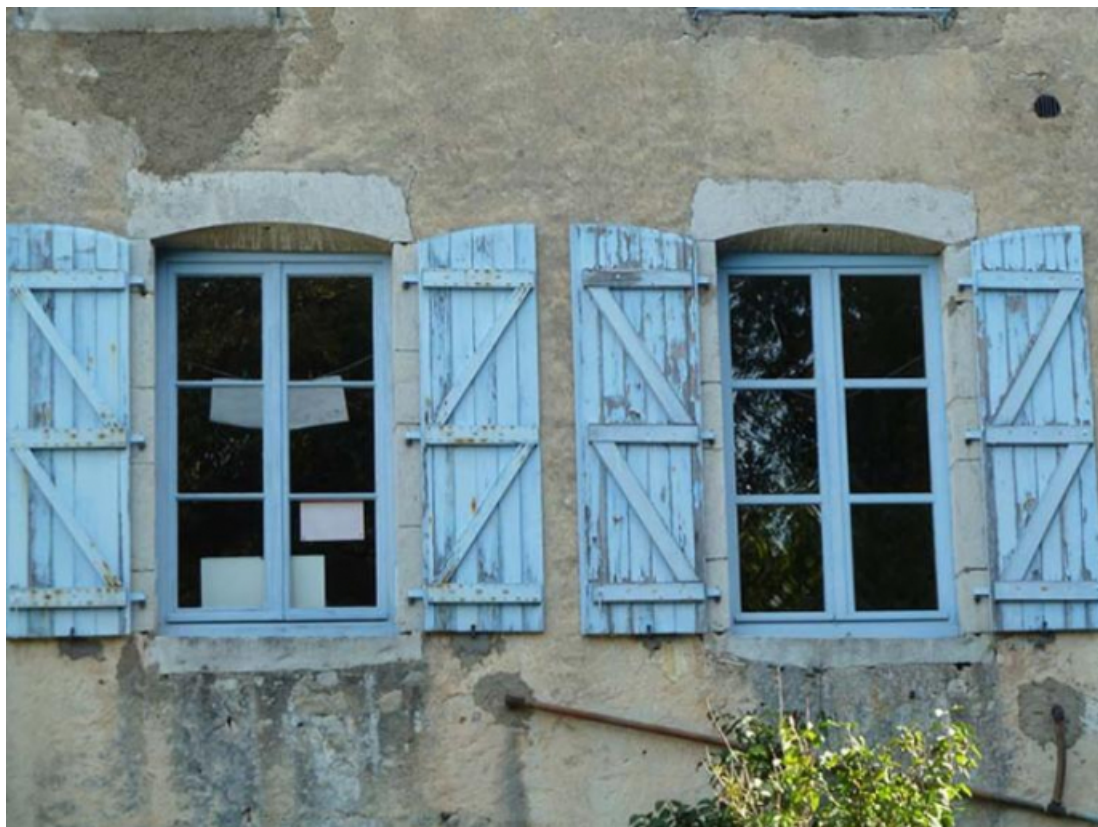
Détail des baies de la façade ouest
