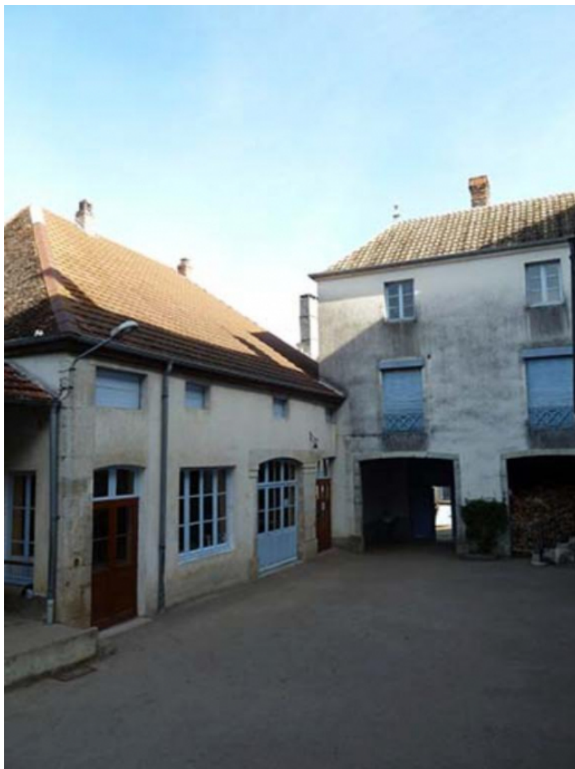
Le porche et la bâtiment situé au nord
