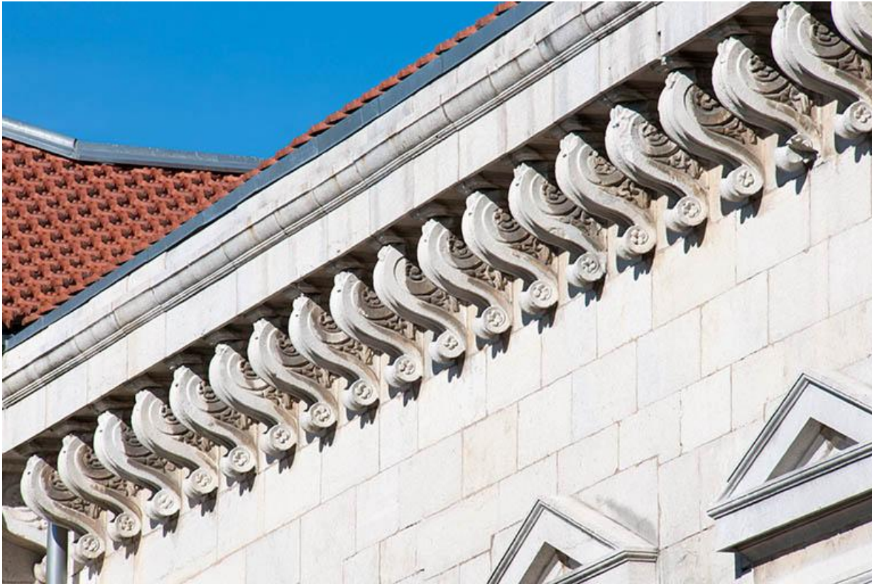
Détail de la corniche 70, Gy Place de la Mairie
