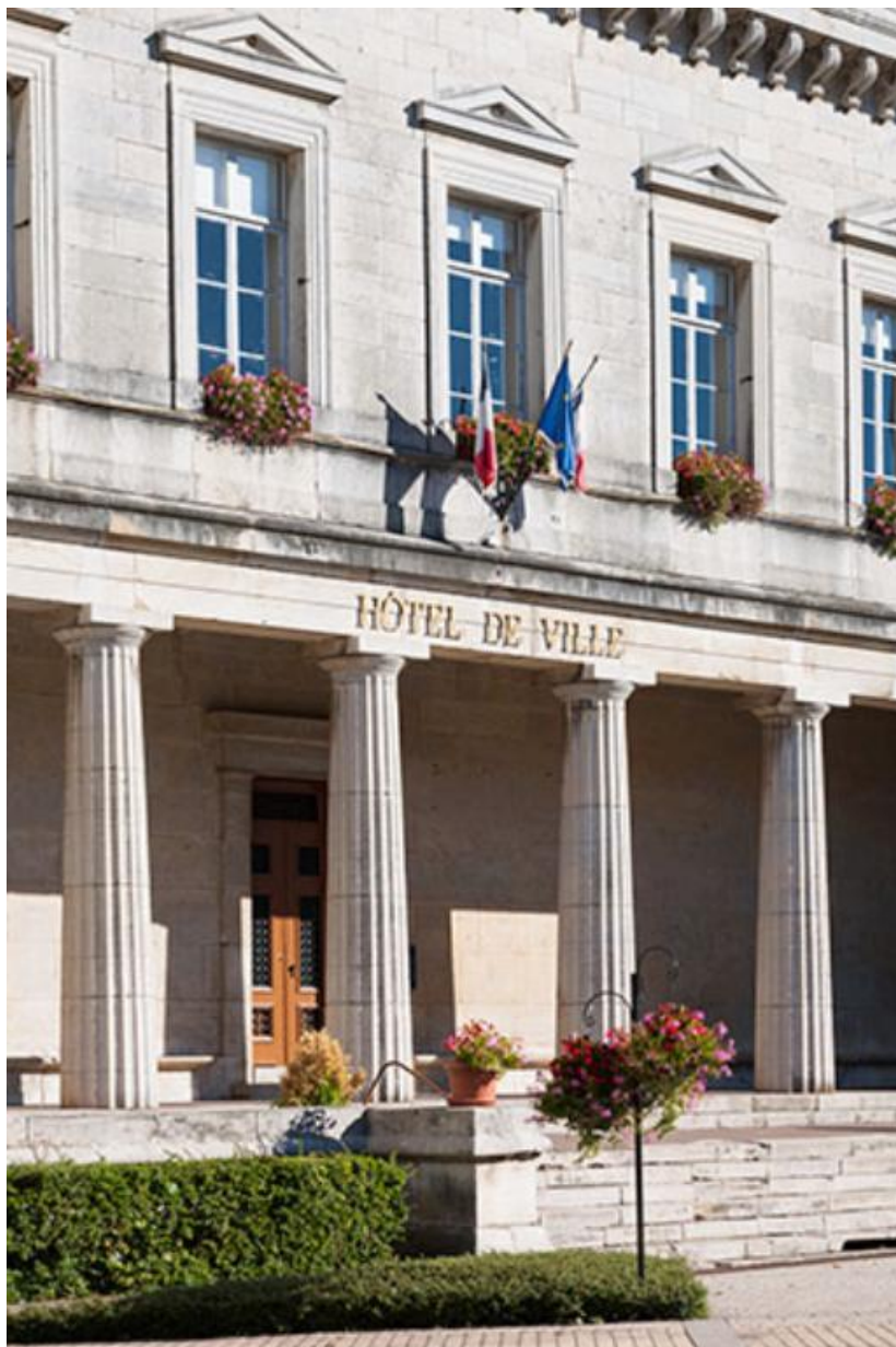
Vue sud-ouest du porche
