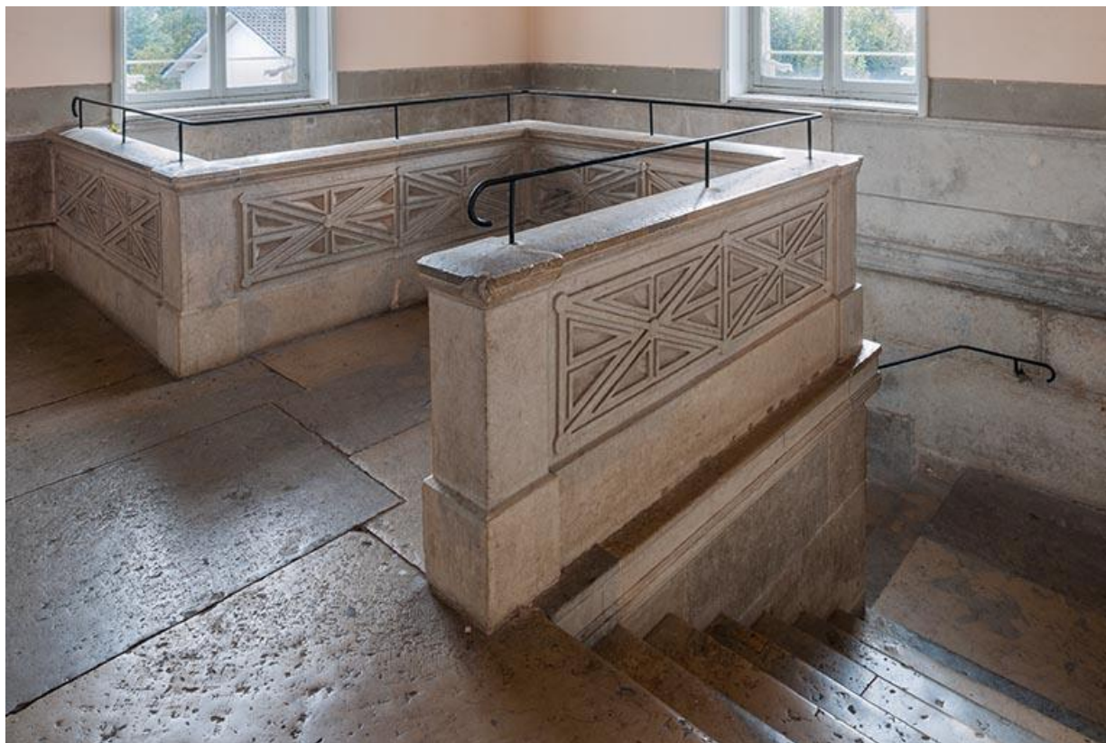
Sommet de l'escalier 70, Gy Place de la Mairie
