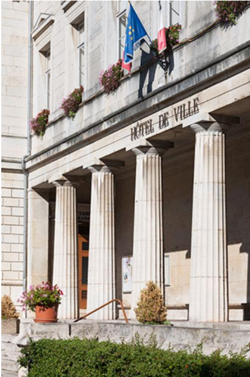
Vue sud-est du porche 70, Gy Place de la Mairie
