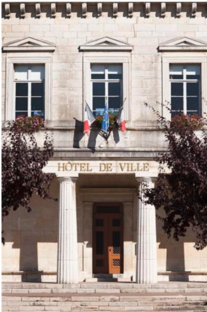
Détail de la partie centrale de la façade sud
