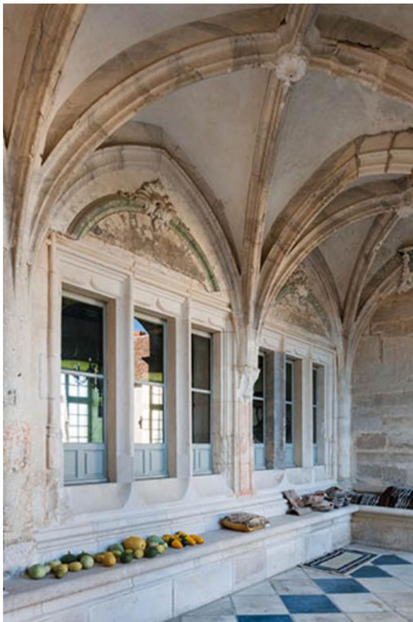
Baies situées au fond de la galerie
