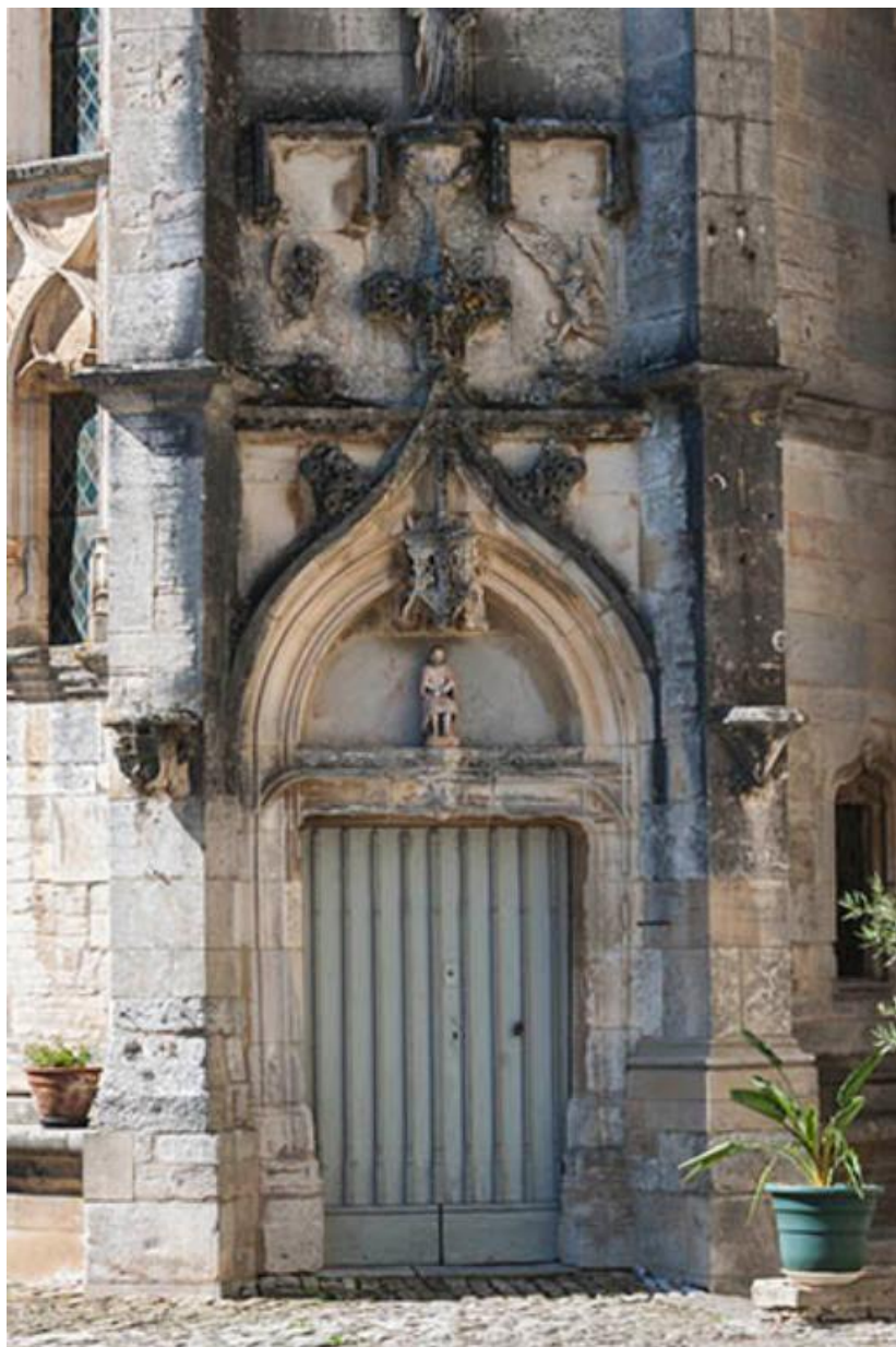
Porte d'entrée de la tour d'escalier
