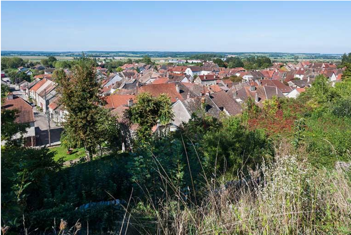
Vue de la ville basse depuis le château
