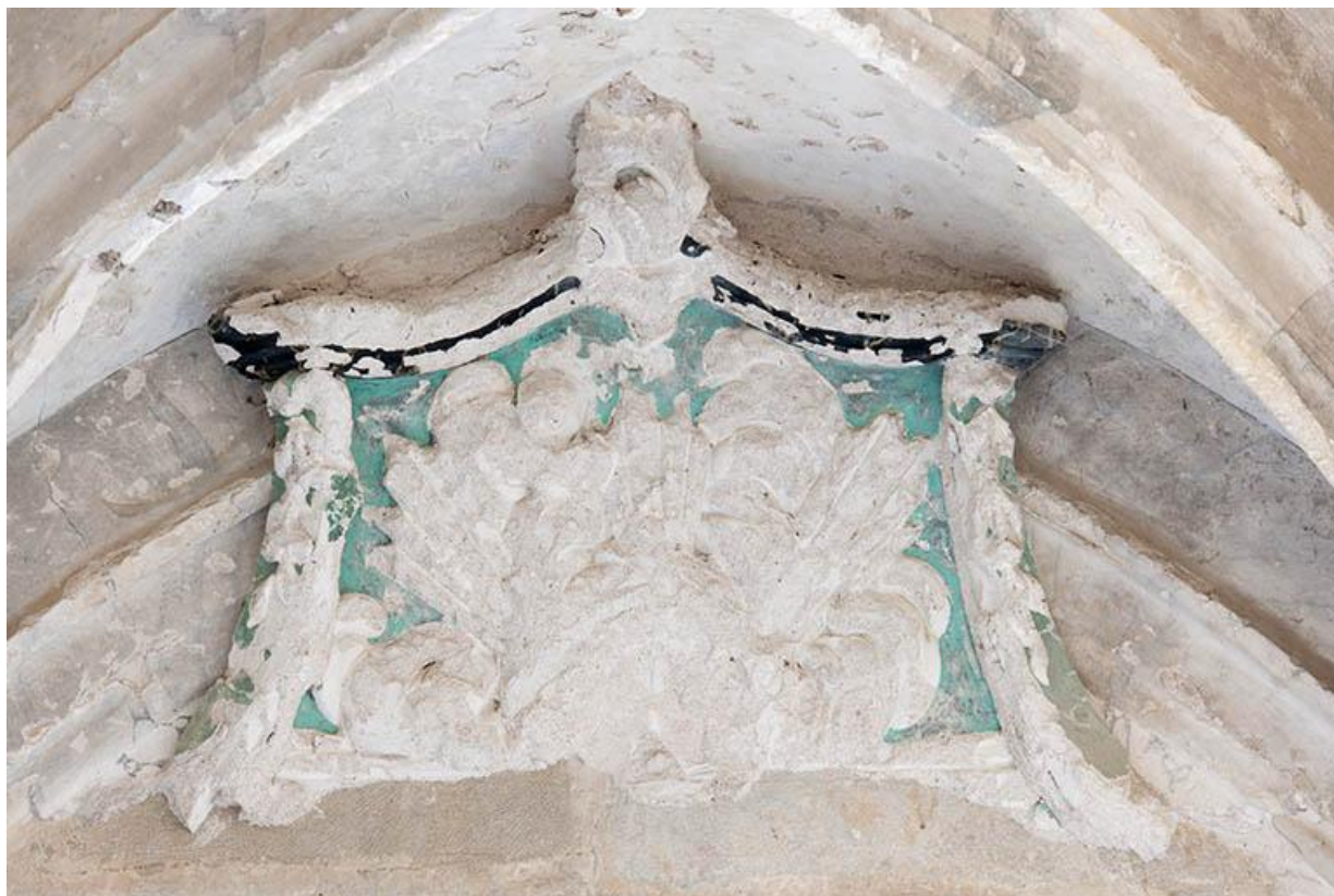
Décor de stuc situé sous la galerie
