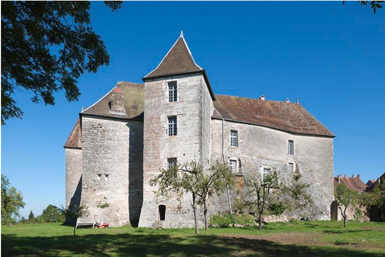
Vue générale ouest
