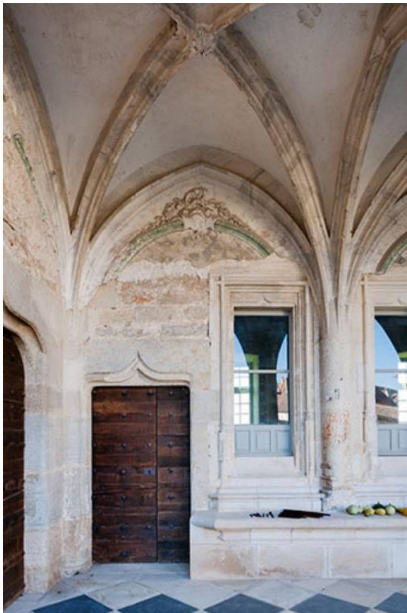
Baies situées au fond de la galerie
