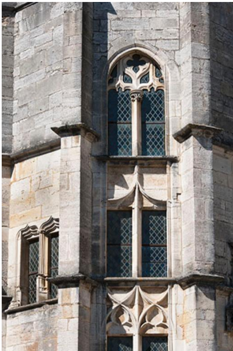
Détail des baies de la tour d'escalier
