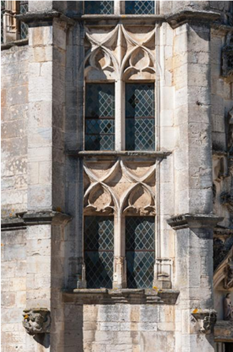
Détail des baies de la tour d'escalier
