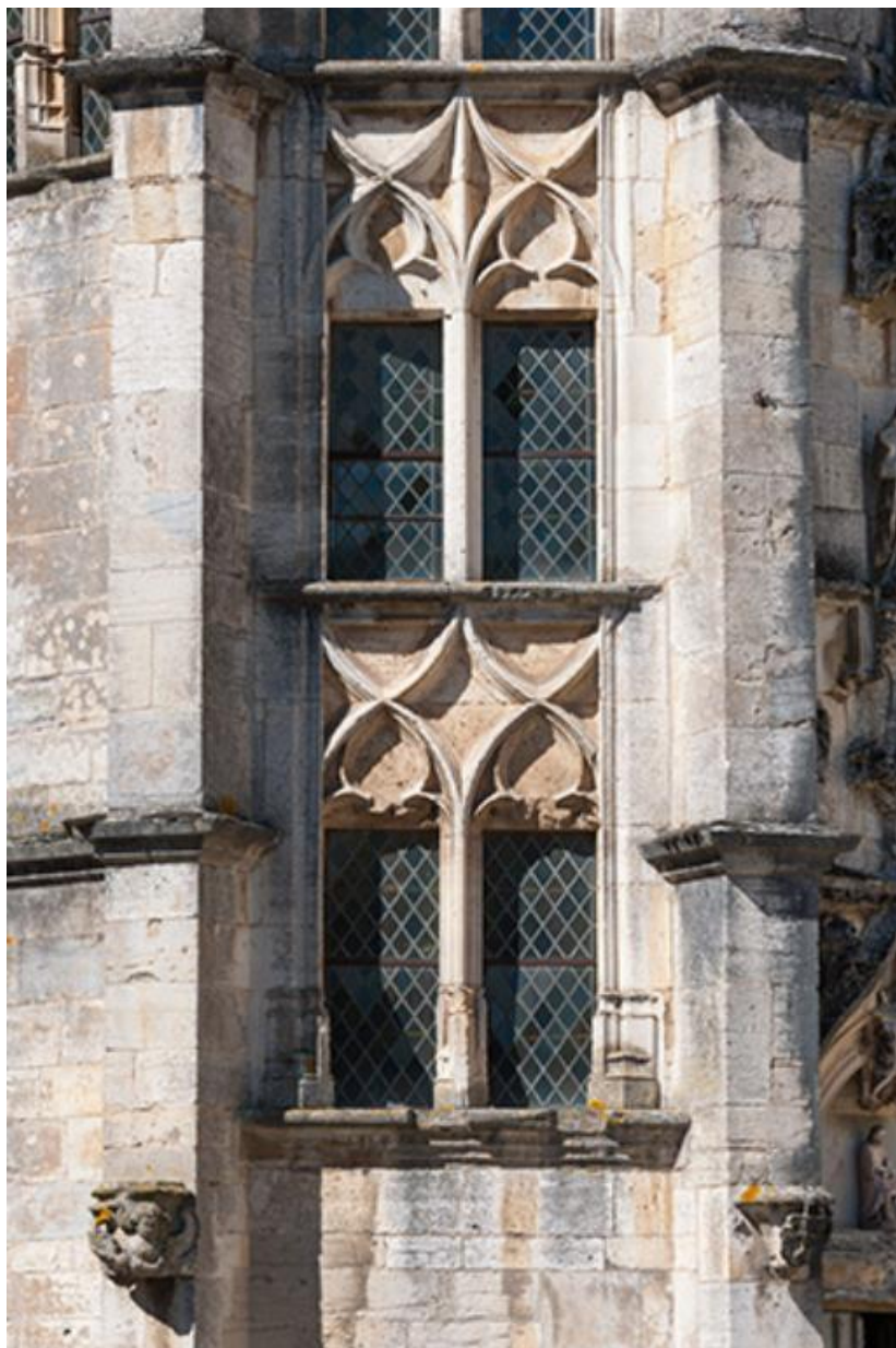
Détail des baies de la tour d'escalier
