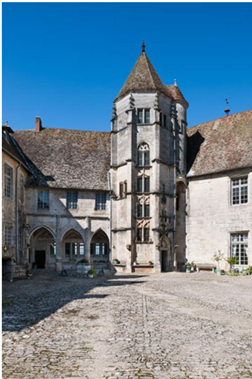
Le tour d'escalier et la galerie
