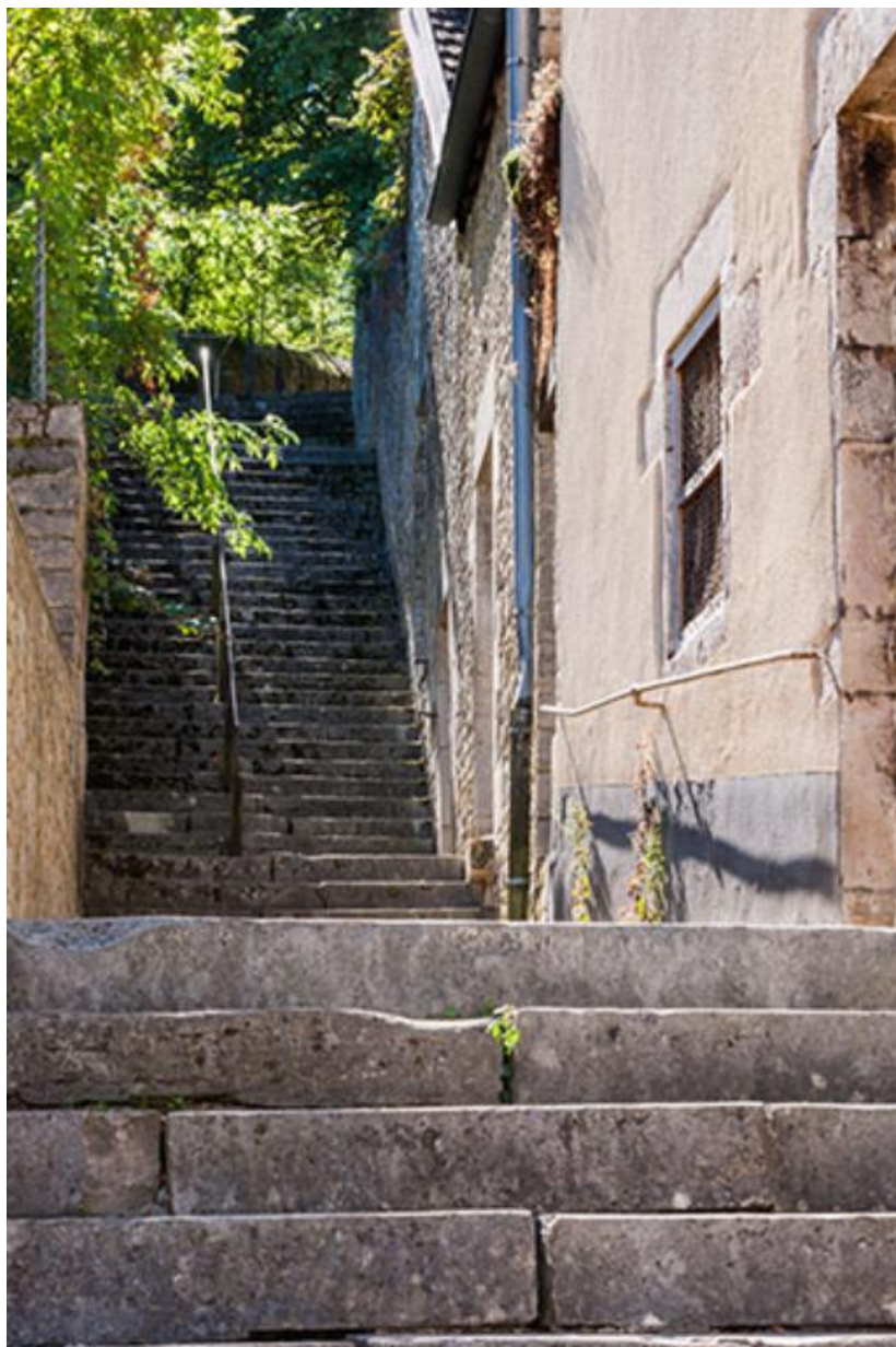
Escalier reliant la Grande Rue au château
