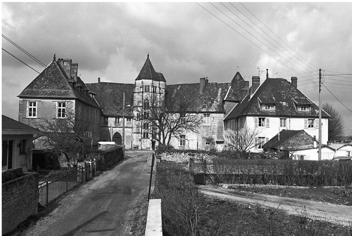
Façade antérieure sur cour.
