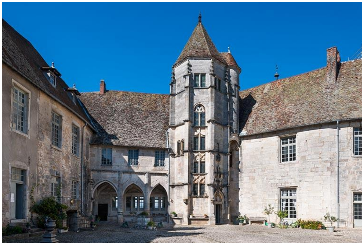
Vue sud depuis l'entrée de la cour
