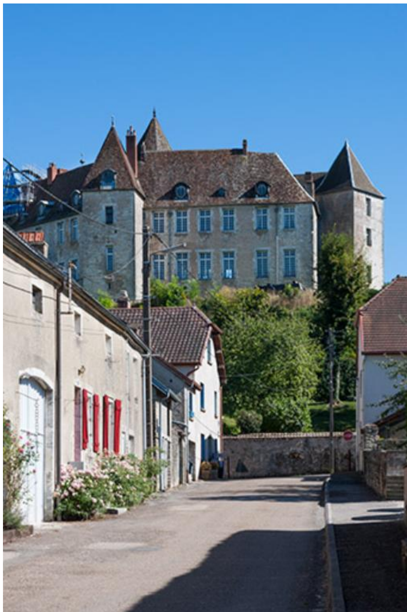
Vue nord, depuis la rue des Terreaux
