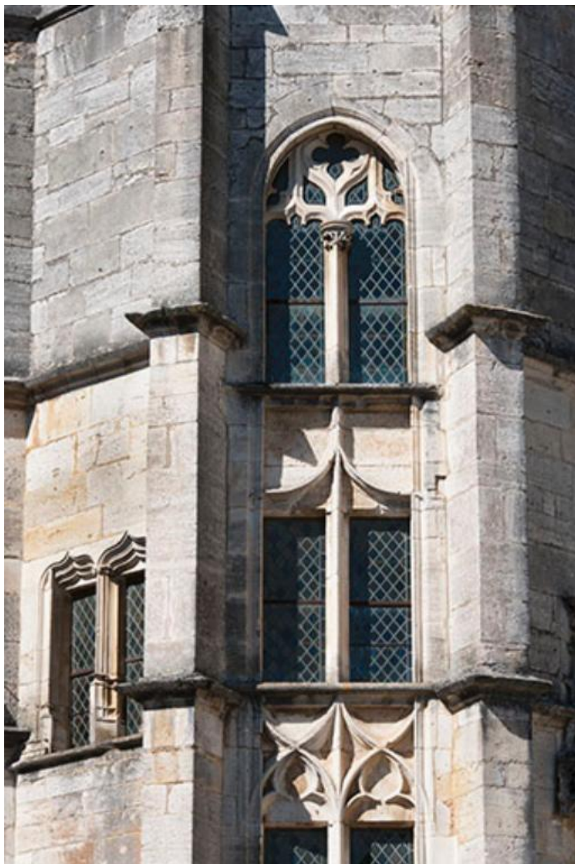
Détail des baies de la tour d'escalier
