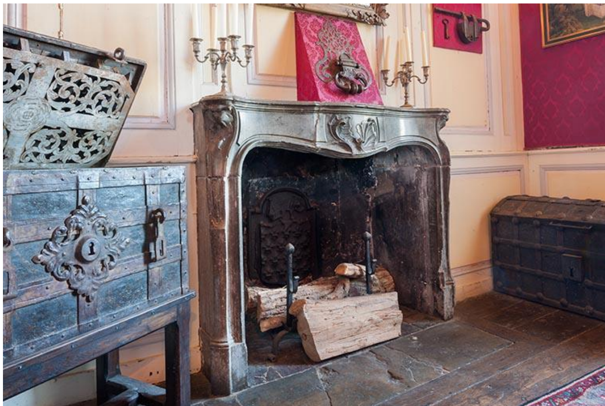
Cheminée en marbre de la tour carrée nord 70, Gy rue du Château
