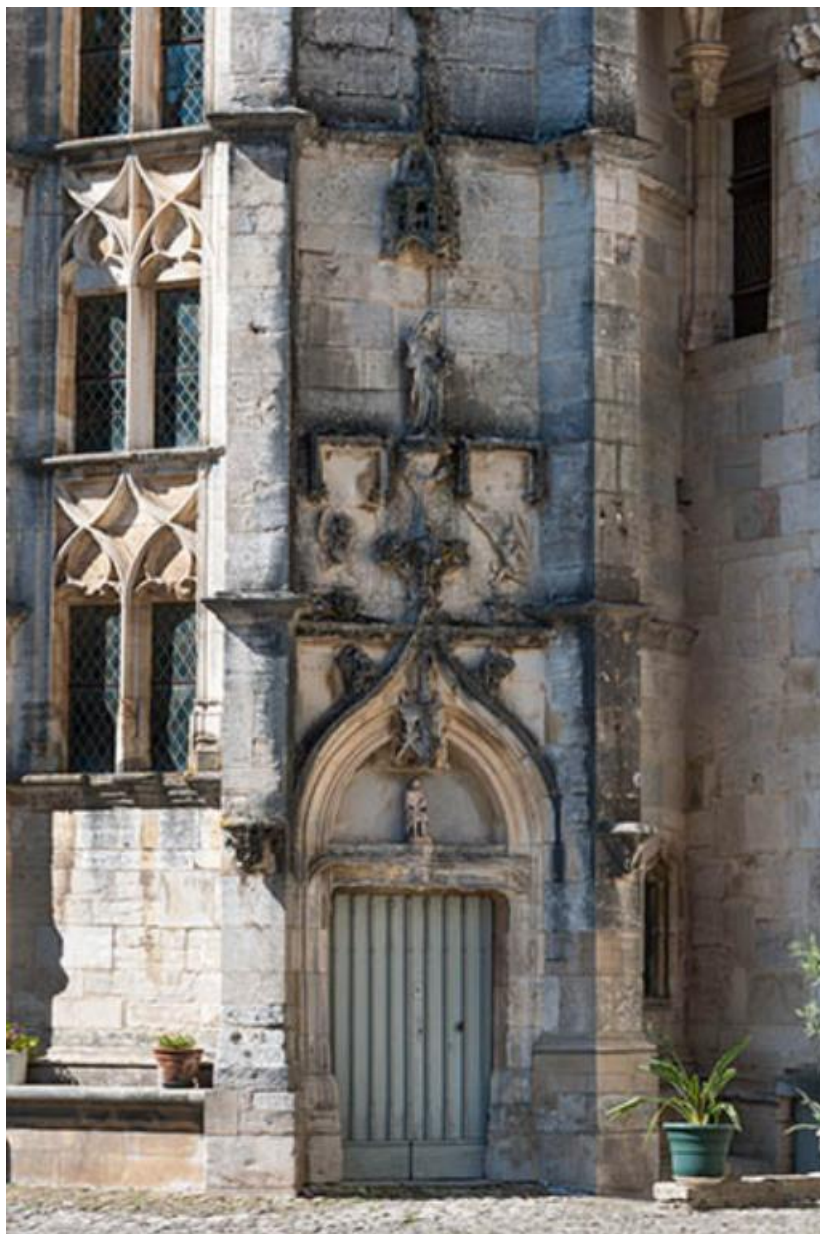
Porte de la tour d'escalier
