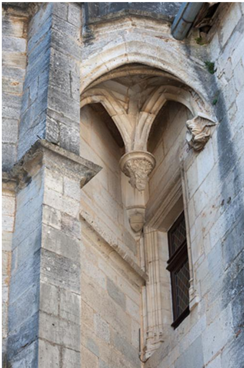
Clé de voûte située sous la tour accolée à la tour d'escalier 70, Gy rue du Château
