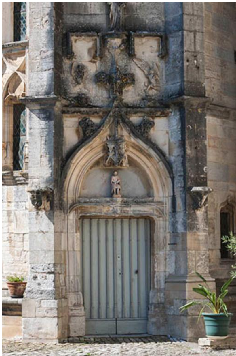
Porte d'entrée de la tour d'escalier
