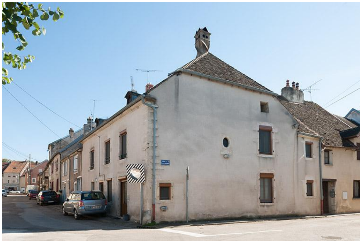
Maison située rue du 10 Septembre 70, Gy
