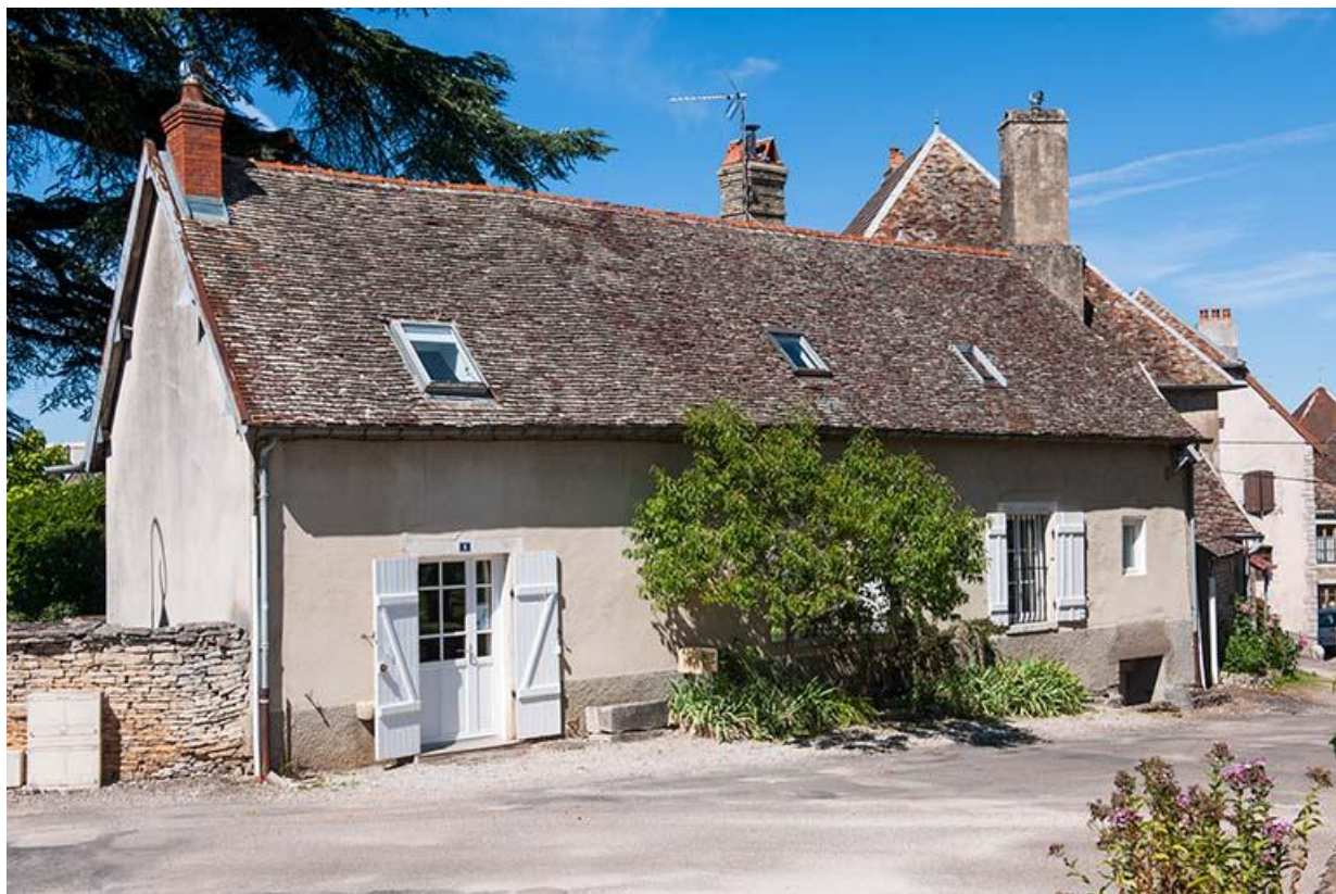
Maison située place de l'Eglise 70, Gy
