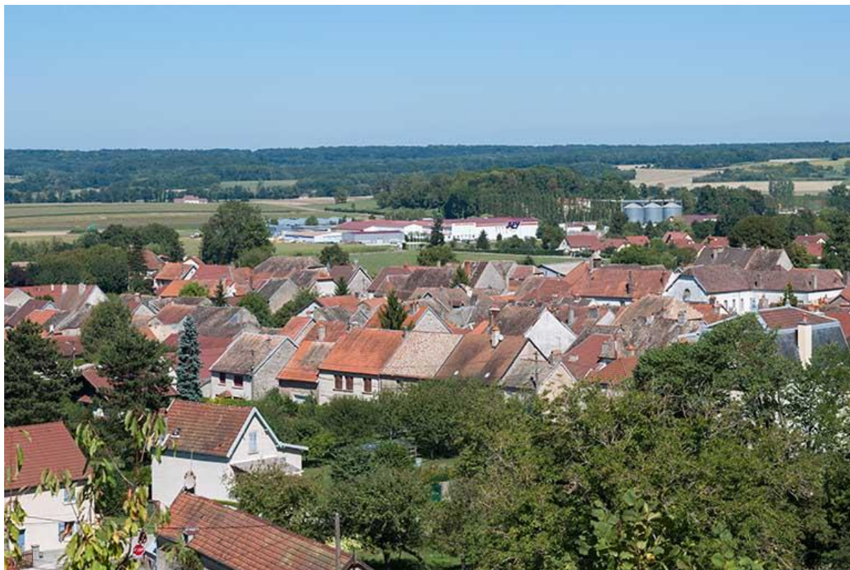
Vue des constructions de la partie basse de la ville 70, Gy
