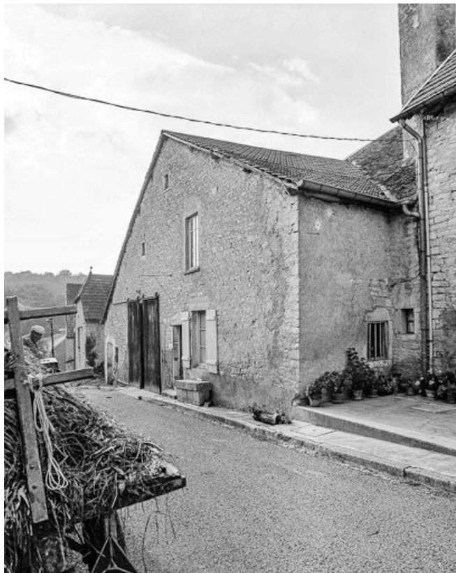
Façades antérieure et latérale droite.
