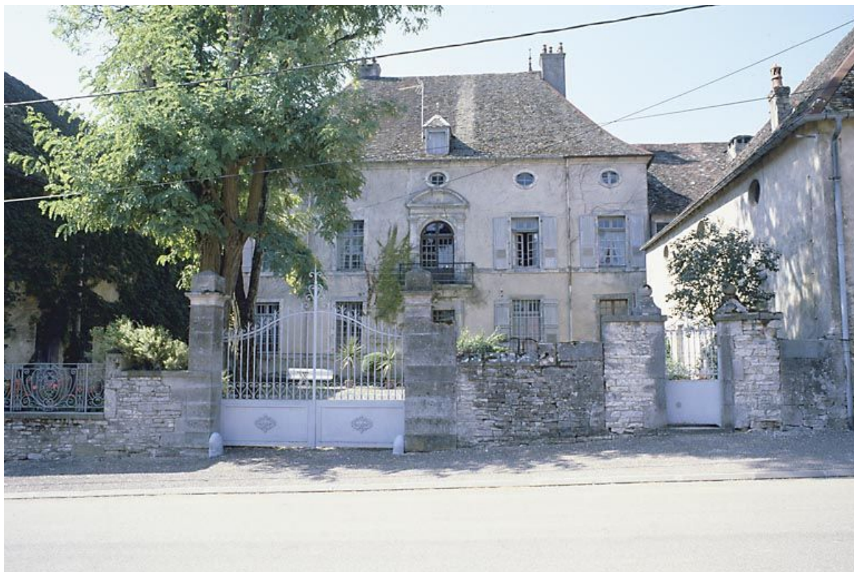
Vue d'ensemble de face depuis la rue.
