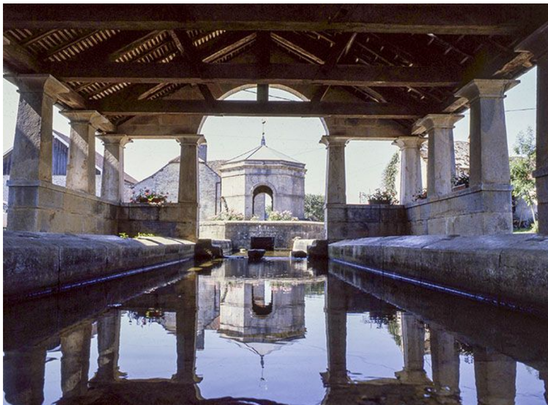
Vue de la fontaine depuis l'intérieur de la halle.
