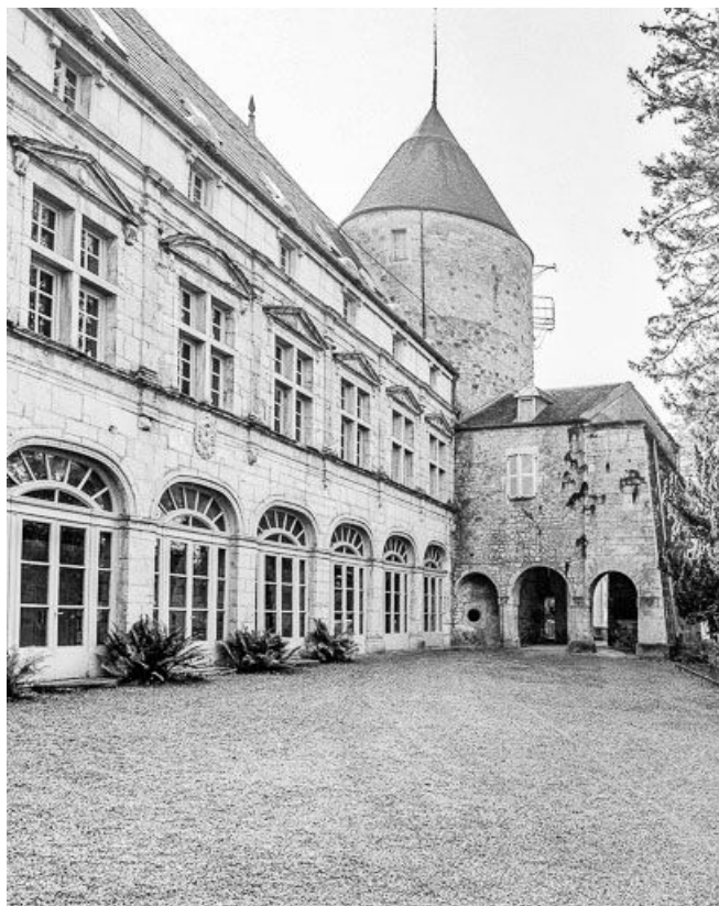
Façade sur cour : partie droite.
