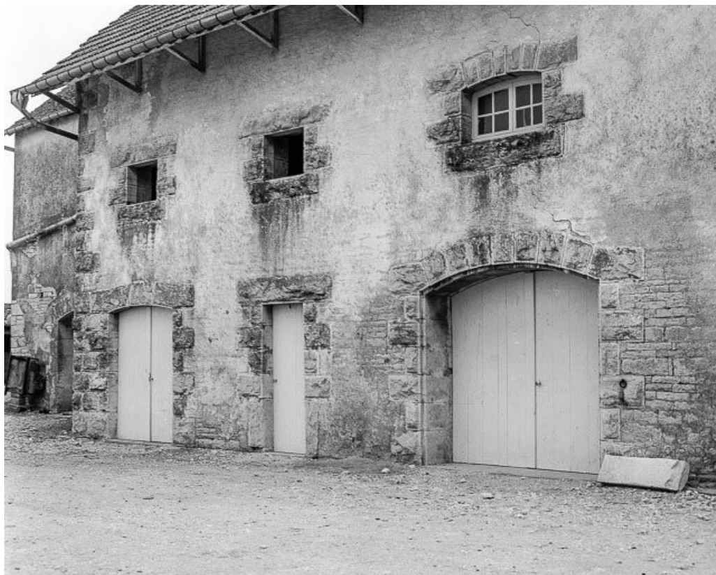
Partie agricole : détail de la façade postérieure.
