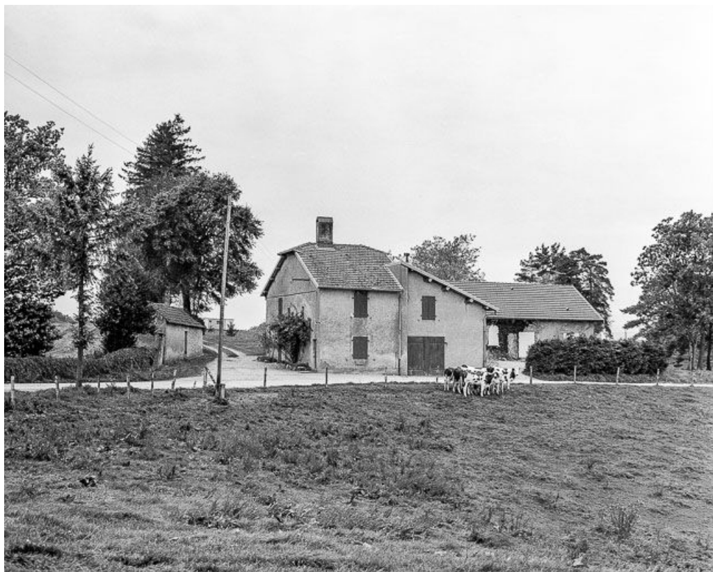
Habitation située à l'entrée de la propriété.
