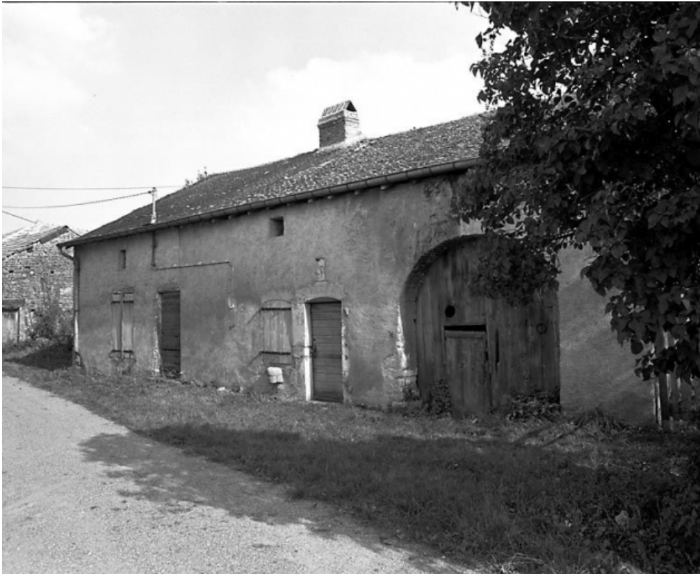
Vue d'ensemble de trois quarts droit. 70, Frasne-le-Château
