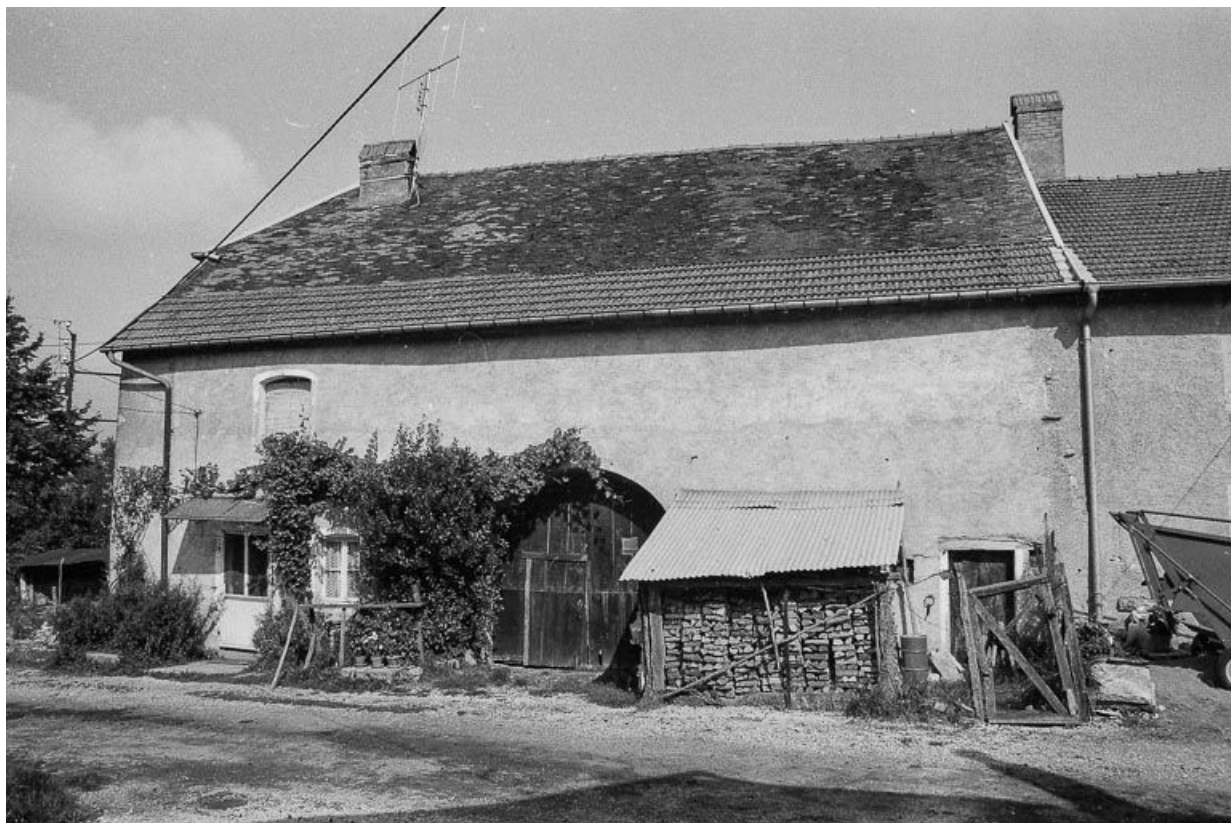
Façade antérieure : partie gauche.
