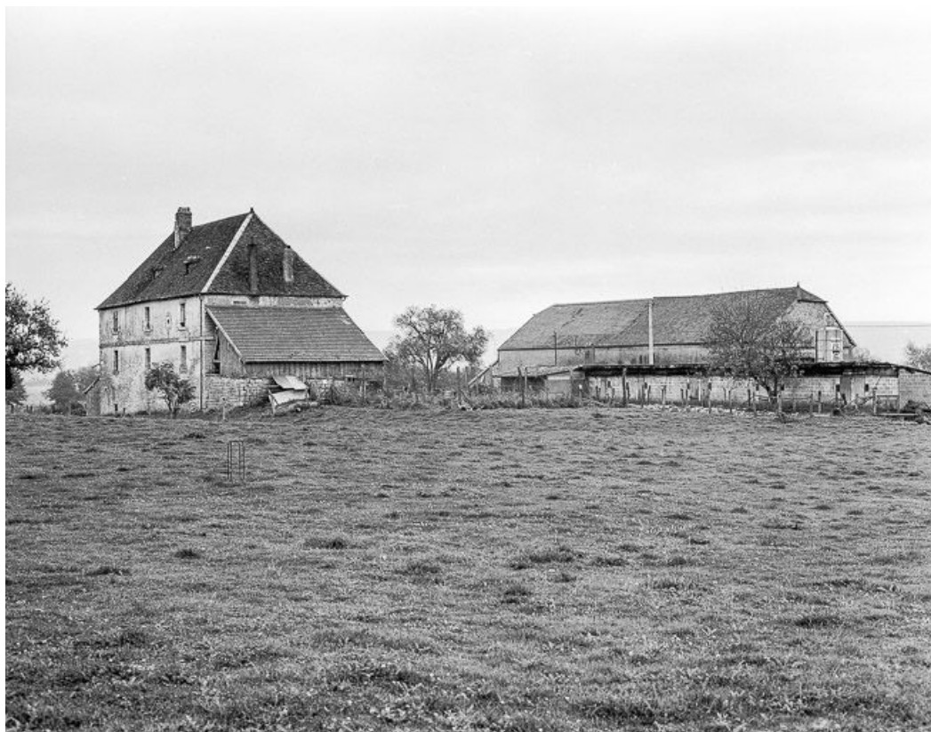
Façades postérieure et latérale droite.
