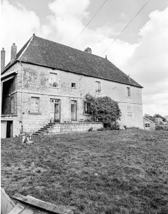
Partie habitation : façade antérieure.
