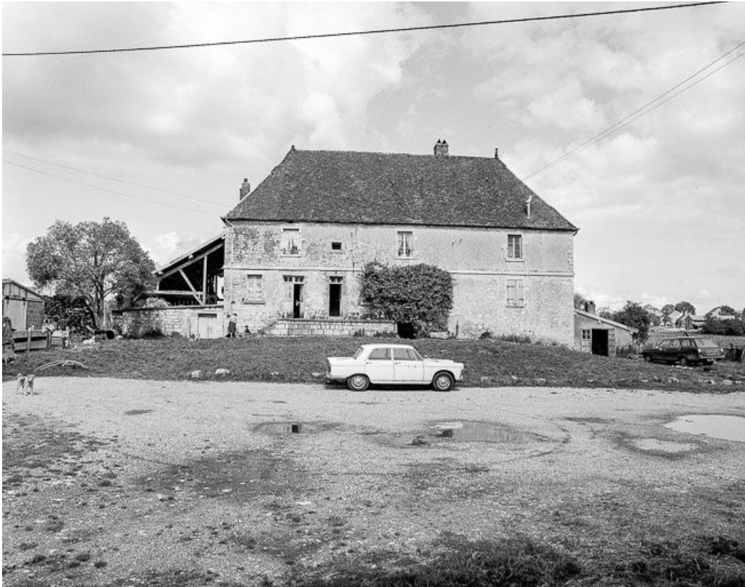
Partie habitation : vue de face.
