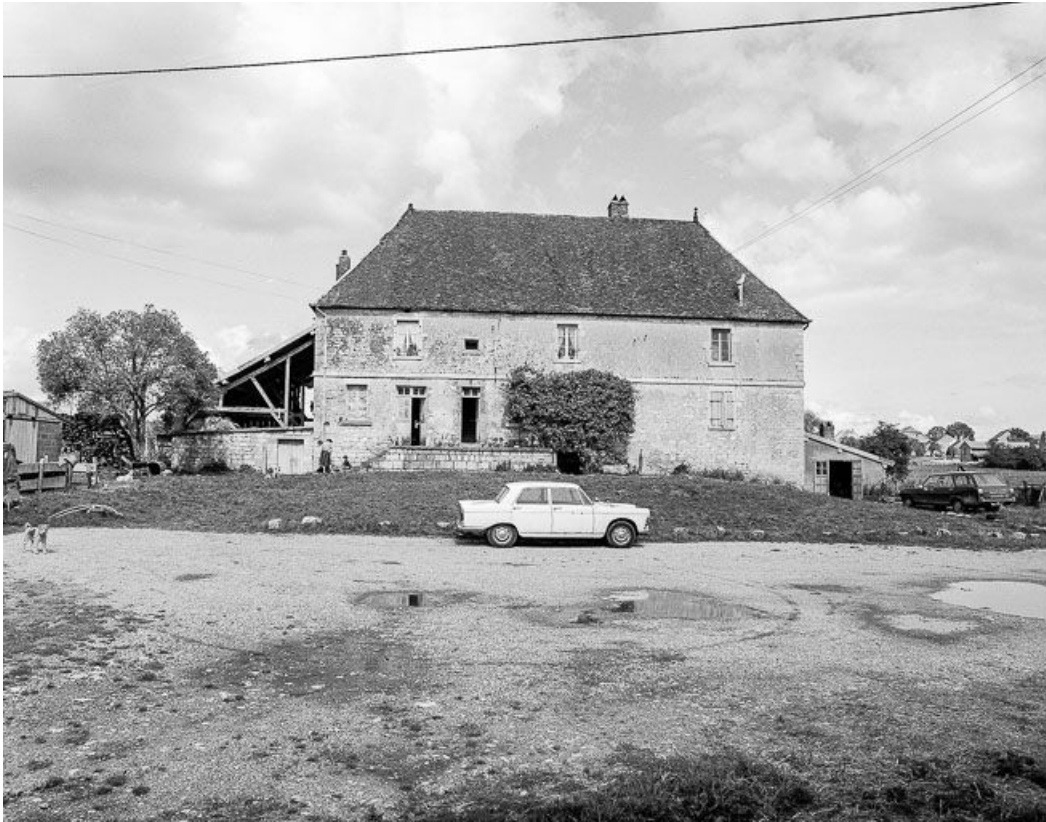
Partie habitation : vue de face.
