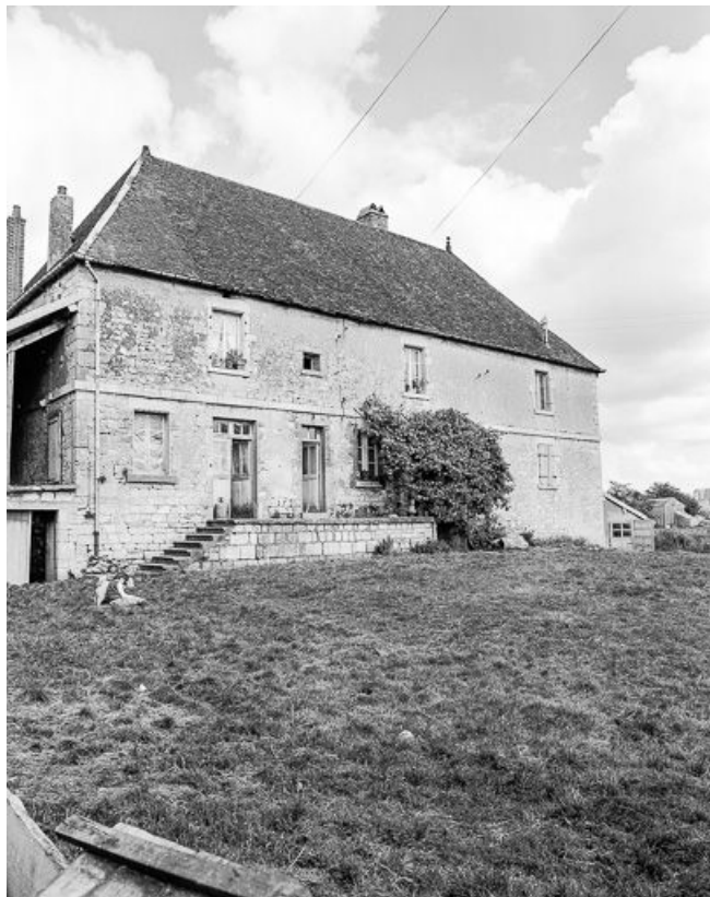
Partie habitation : façade antérieure.
