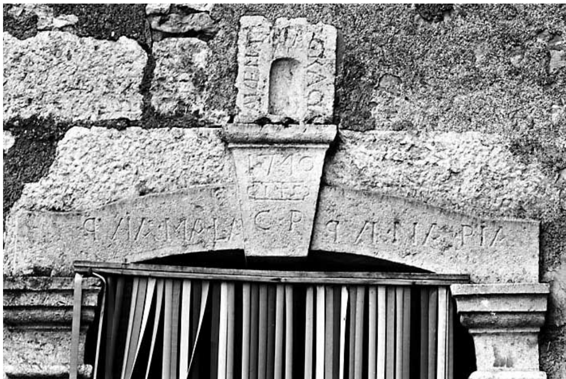
Détail du linteau de la porte d'entrée de l'habitation.
