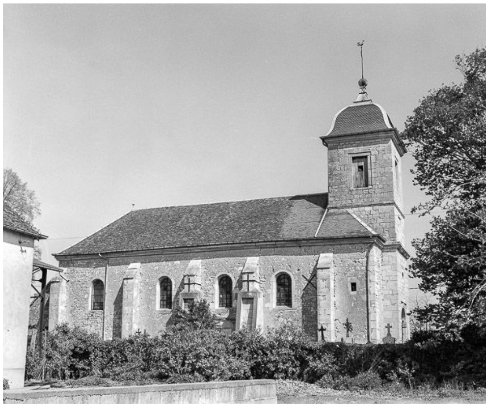
Extérieur : clocher et face latérale gauche.
