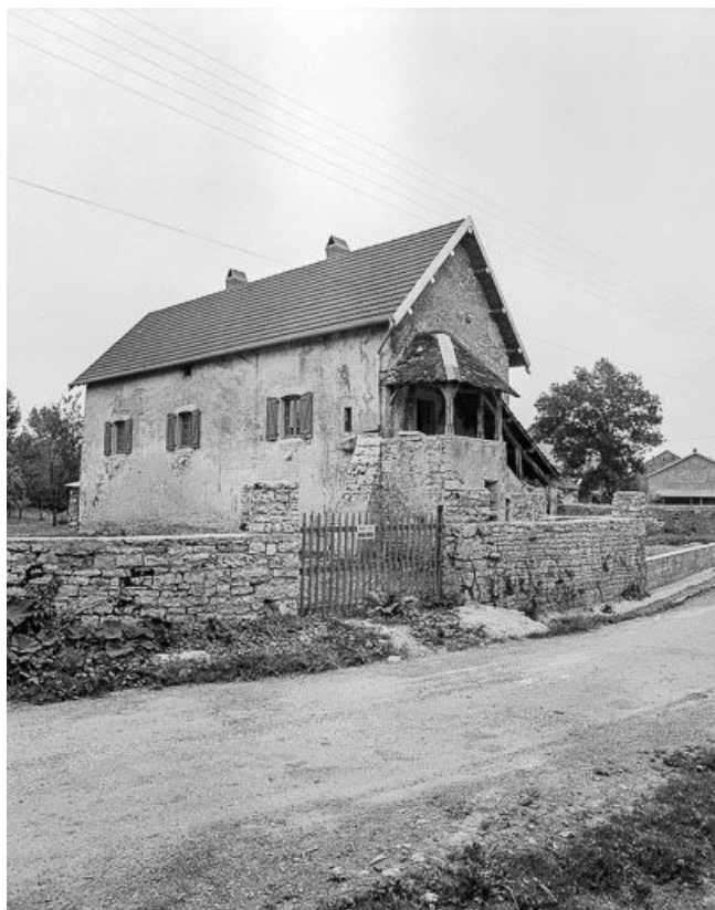
Ferme avec escalier extérieur, vue de trois quarts gauche.
