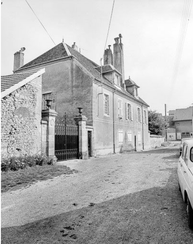
Façades antérieure et latérale droite.
