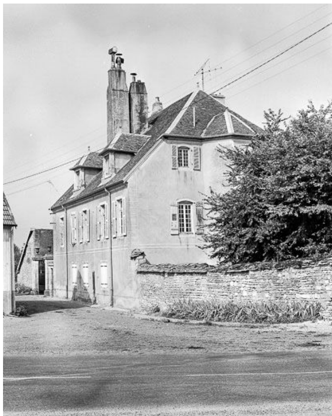
Façades antérieure et latérale droite.
