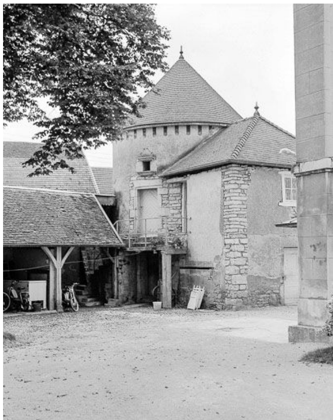
Tour avec logement et colombier à gauche du bâtiment principal.
