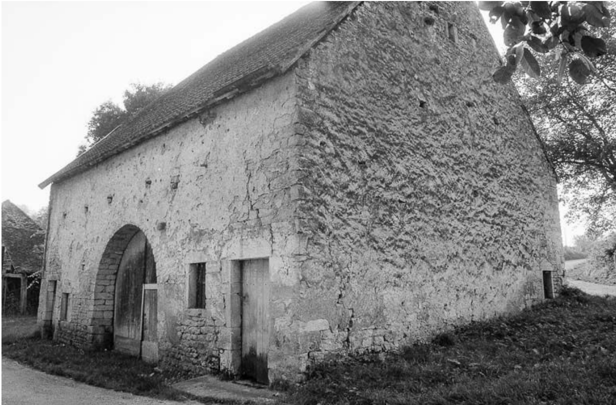
Le moulin : partie agricole vue de trois quarts droit.
