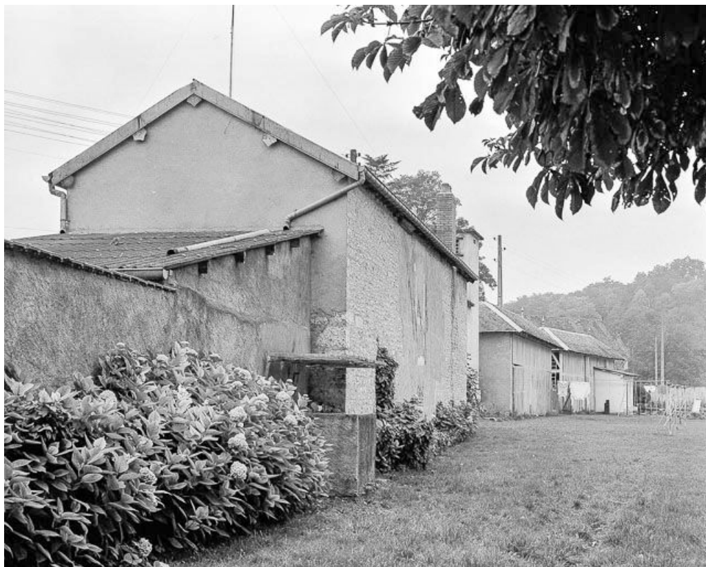
Les communs à l'intérieur de l'enclos, le long du mur de clôture. A gauche, la poste. 70, Choye place de Coligny
