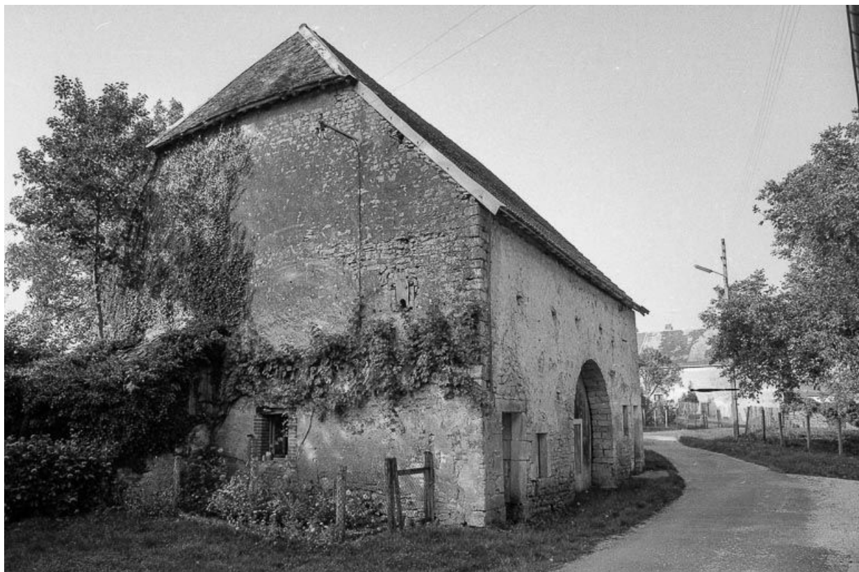
Le moulin : partie agricole vue de trois quarts gauche.
