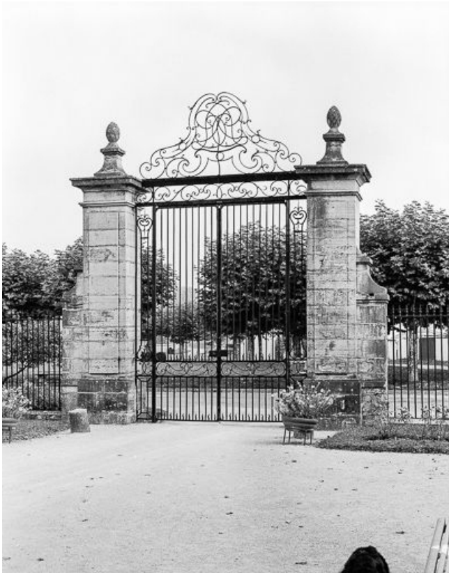
Vue du portail d'entrée depuis la cour.
